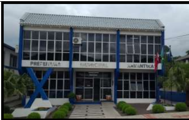
Figura 42 - Fachada Frontal do Centro Administrativo, voltada para a Rua Prefeito Octávio Urbano Simon
