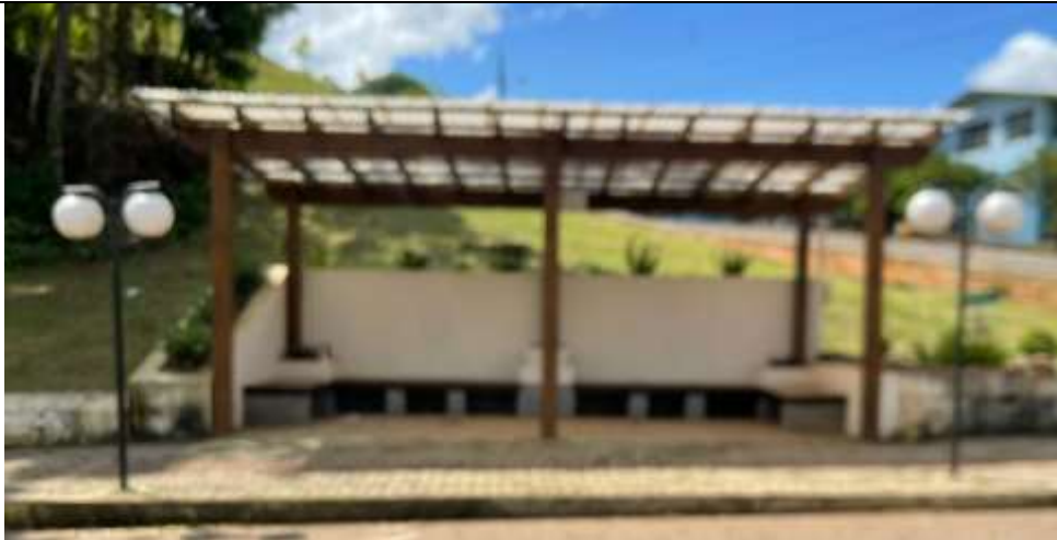
Figura 44 - Imagem da Fachada Frontal do Pergolado
