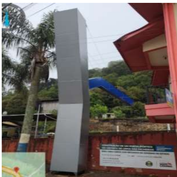
Figura 50 – Imagem da Vista da Base/Pilar do Pórtico em ACM, na cor cinza, objeto da instalação de Cascata de Led
