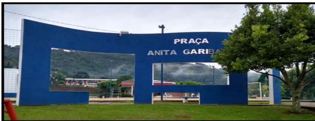
Figura 34 – Imagem da fachada do Pórtico, voltada para a Rua Irineu Bornhausen
