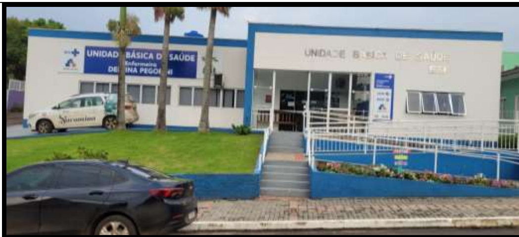
Figura 40 - Fachada Frontal da Unidade Básica de Saúde, para a Rua Prefeito Octávio Urbano Simon
