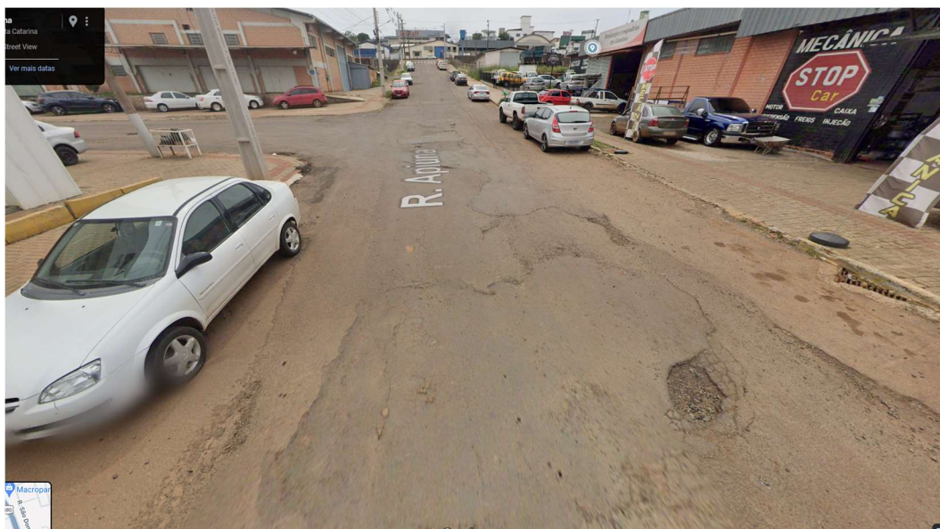
Figura 4 - Remoção e recomposição na área sobre a OAC na Rua Apiúna
