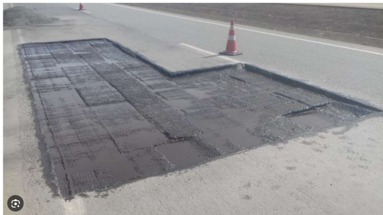
Figura 23 - Fresagem descontínua do pavimento
