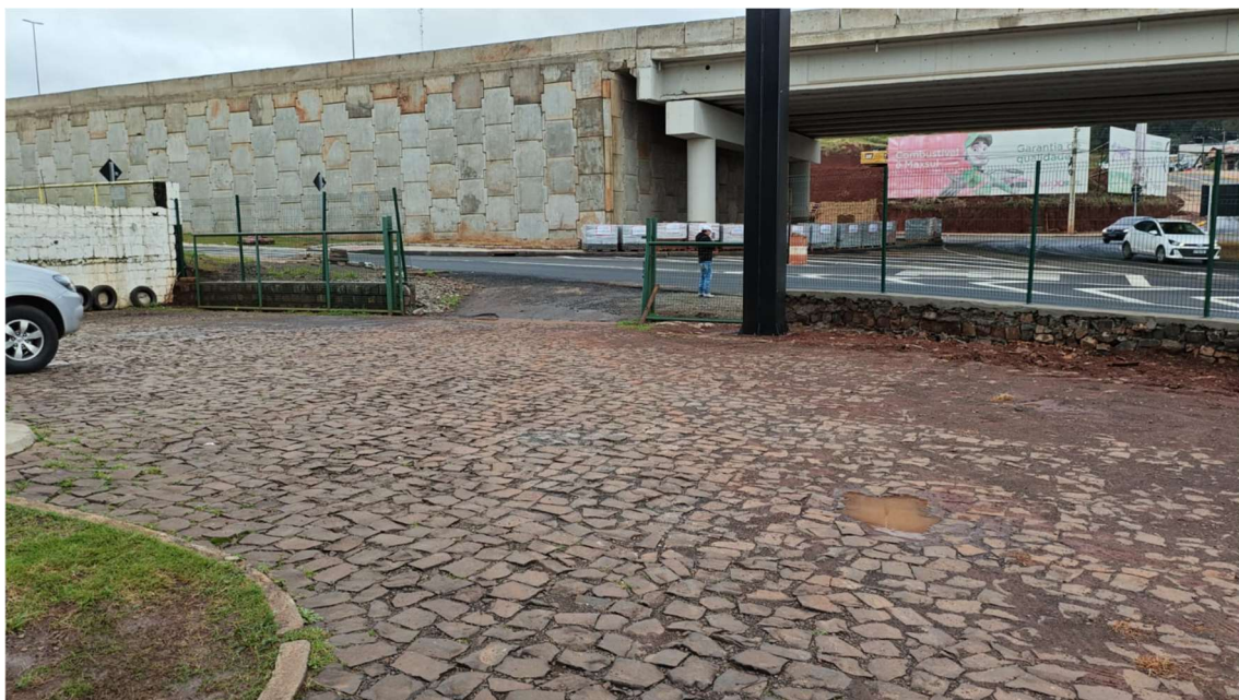
Figura 12 - Vista a região para conformação com aterro e pavimentação no acesso ao comércio junto a marginal
