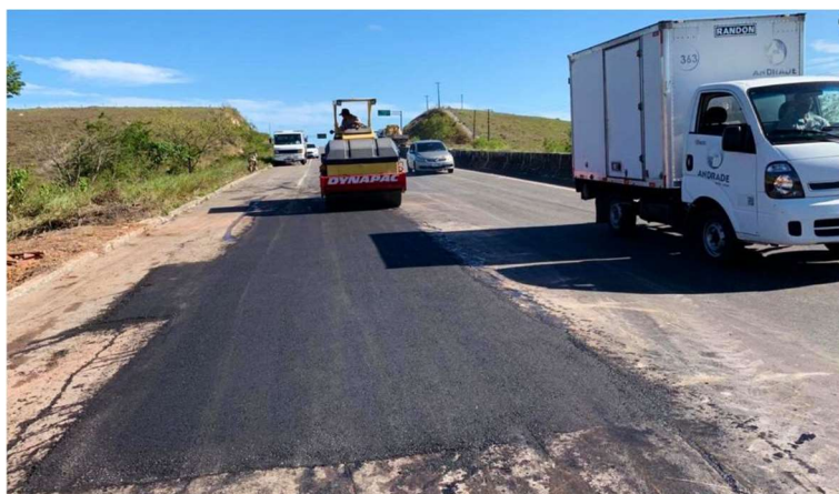
Figura 20 - Recomposição do revestimento asfáltico - Capa final ou selo para liberação ao tráfego
