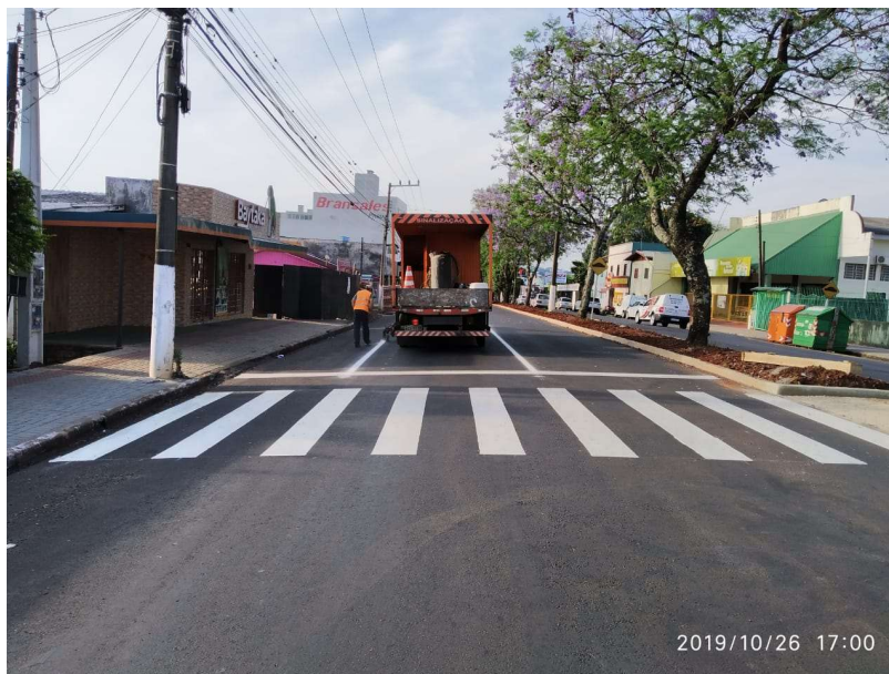
Figura 28 - Detalhe faixa de segurança - sinalização horizontal
