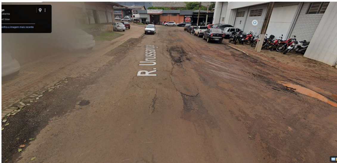
Figura 5 – Área com remoção e recomposição sobre a OAC na Rua Urussanga
