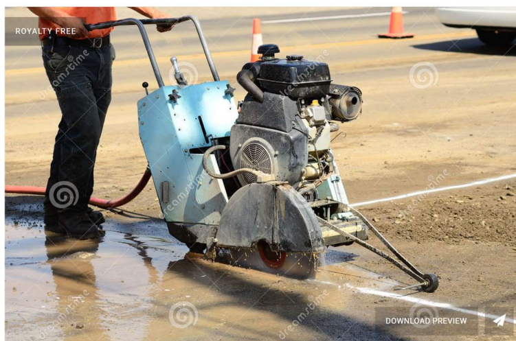
Figura 15 - Corte do pavimento com serra diamantada
