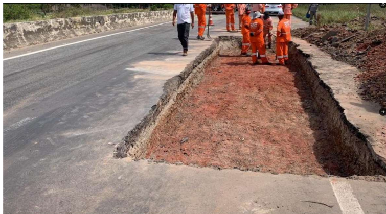
Figura 16 - Escavação confinada para remendo profundo com exposição da estrutura existente
