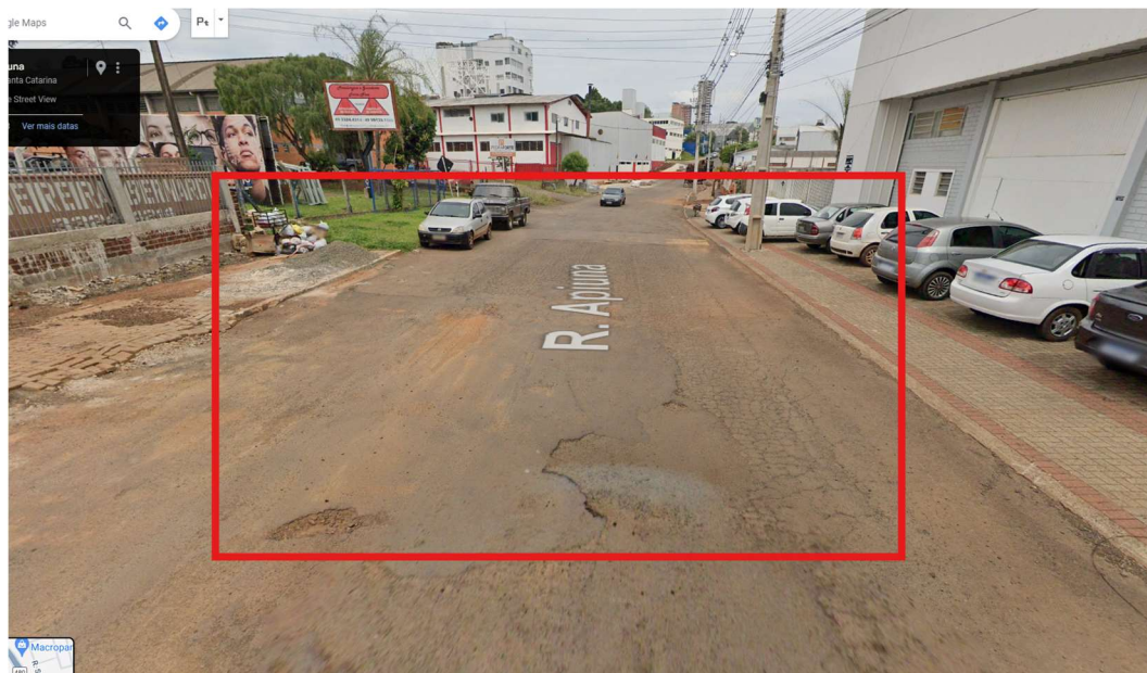
Figura 8 - Área de remendo profundo (reforço com rocha detonada)
