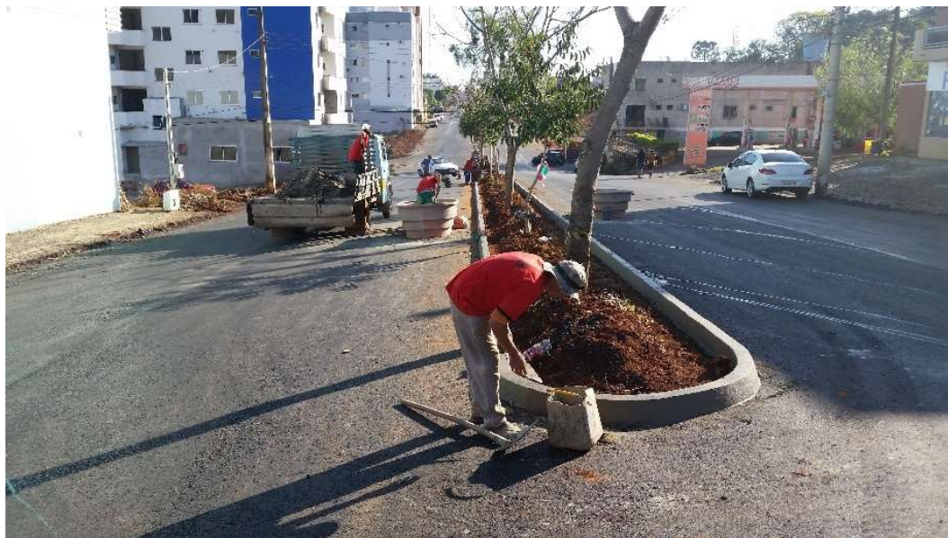
Figura 27 - Execução de novo meio-fio (Serviço Complementar)
