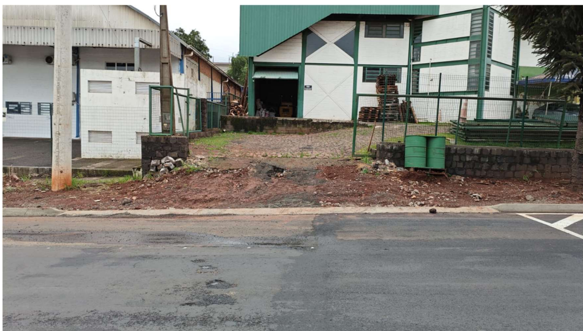
Figura 13 - Vista a região para aterro e pavimentação no acesso ao comércio junto a Av. Leopoldo Sander
