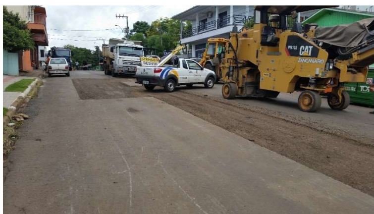
Figura 21 - Detalhe da patrulha mobilizada para o serviço de fresagem de pavimento
