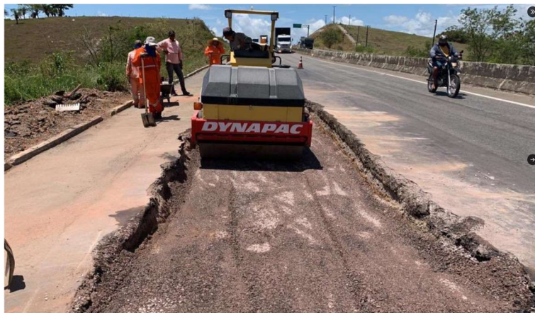
Figura 19 - Execução das camadas granulares (camada de bloqueio, macadame seco e brita graduada)
