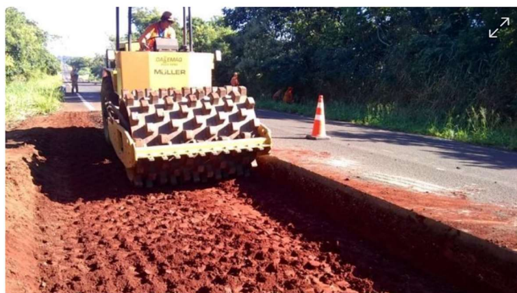
Figura 17 - Regularização e compactação do subleito
