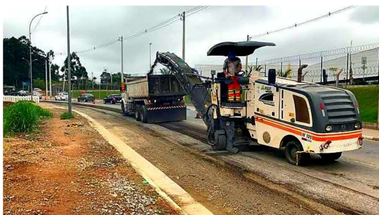
Figura 22 - fresagem contínua do pavimento
