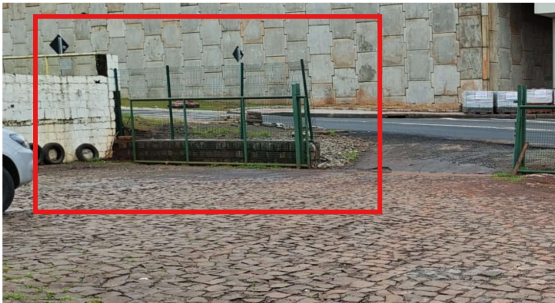
Figura 14 - Muro no alinhamento para aumentar a altura para receber o passeio
