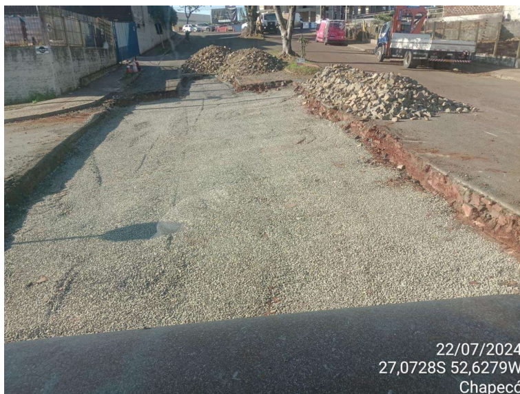
Figura 18 - Execução da camada de bloqueio na área de recomposição
