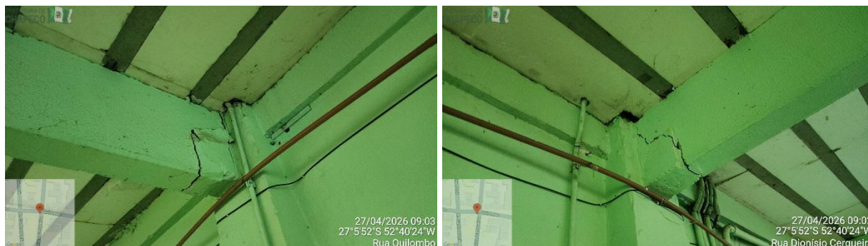
Figura 1 - Consolos a serem reforçados com apoio metálico.
