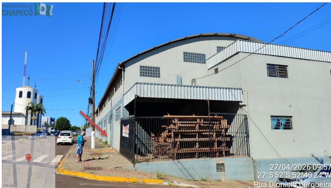
Figura 3 - Local para instalação da nova medição de energia.
