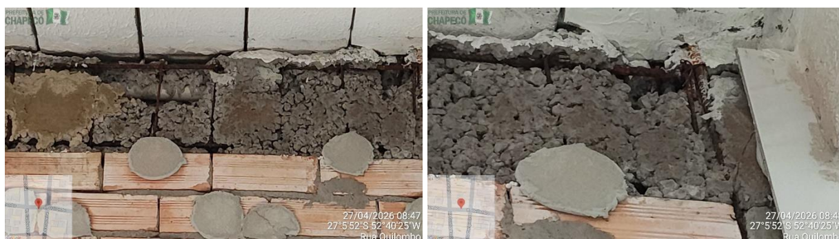
Figura 2 - Viga da cozinha para ser recomposta.
