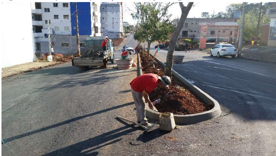
Figura 13 - Execução de novo meio-fio (Serviço Complementar)
