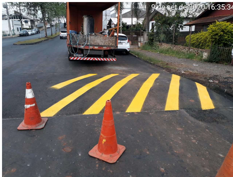
Figura 15 - Sinalização de lombadas físicas. Importante sinalizar horizontalmente para liberação do trânsito
