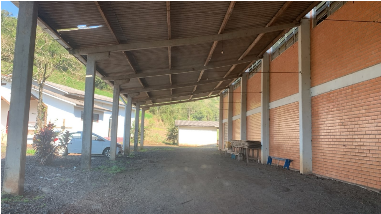
Lateral onde receberá piso e mureta
