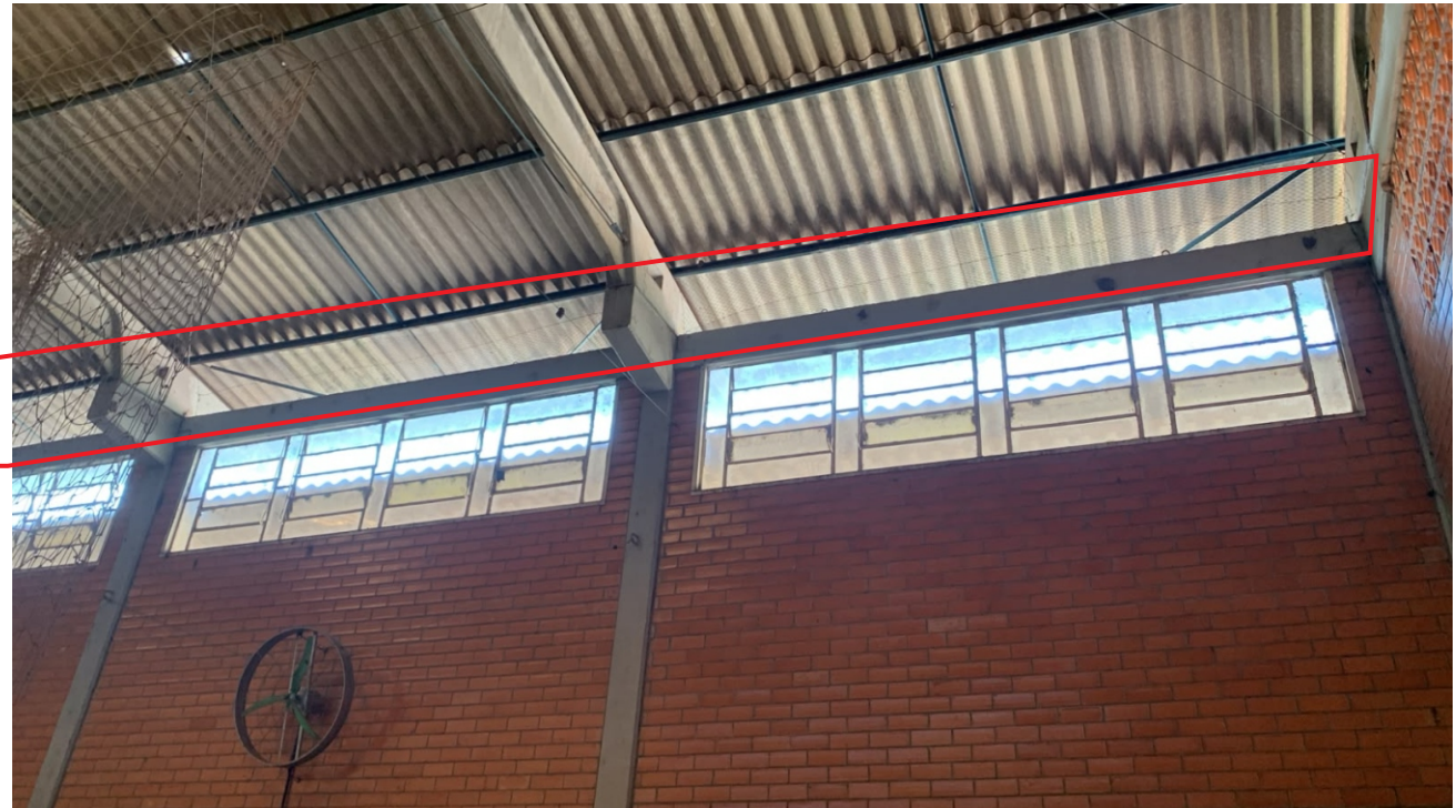
Vão aberto - fechar com aluzinco, ambos lados.
