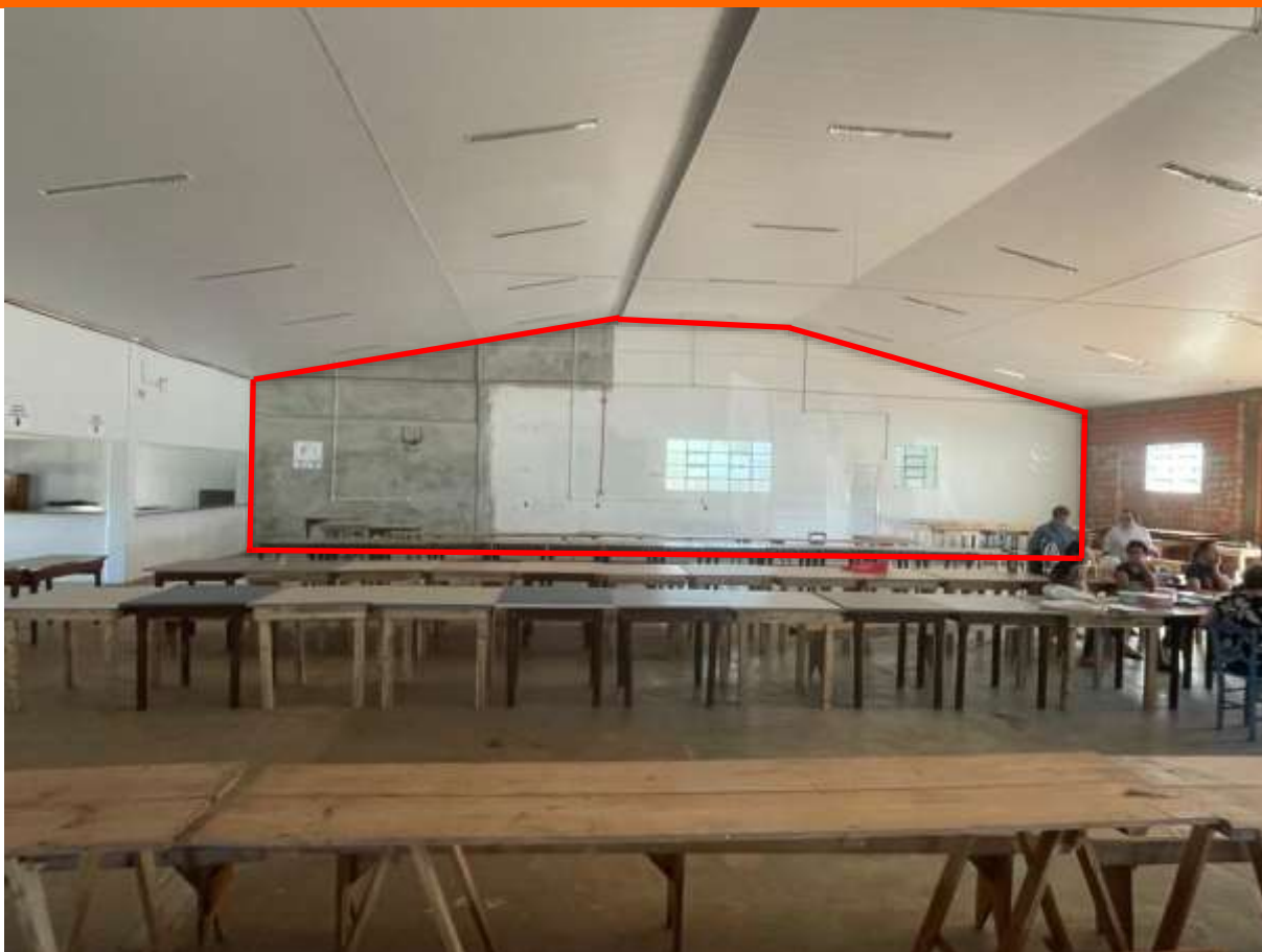
Figura 1- Alvenarias a serem demolidas
