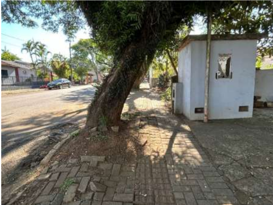
Foto 4 – Árvore escorada com risco de queda e raízes danificando o passeio
