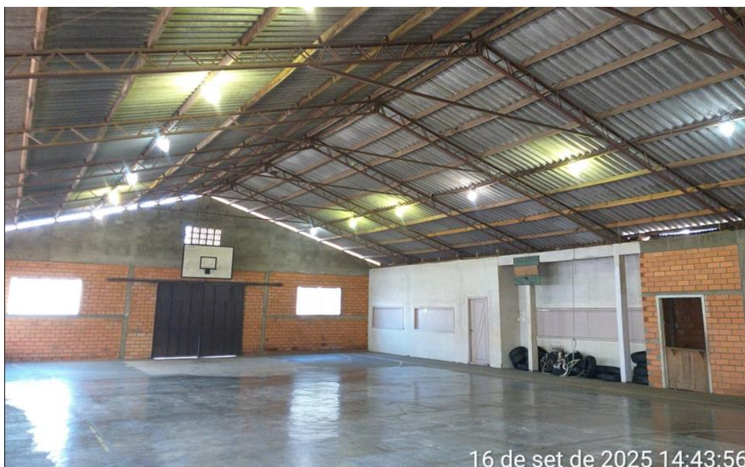
Imagem 04– Cobertura e quadra.
