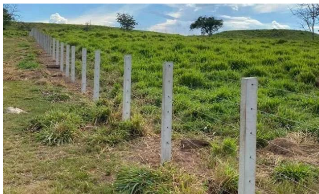
Imagem 8 - Modelo de cerca com mourão e fios de arame;
