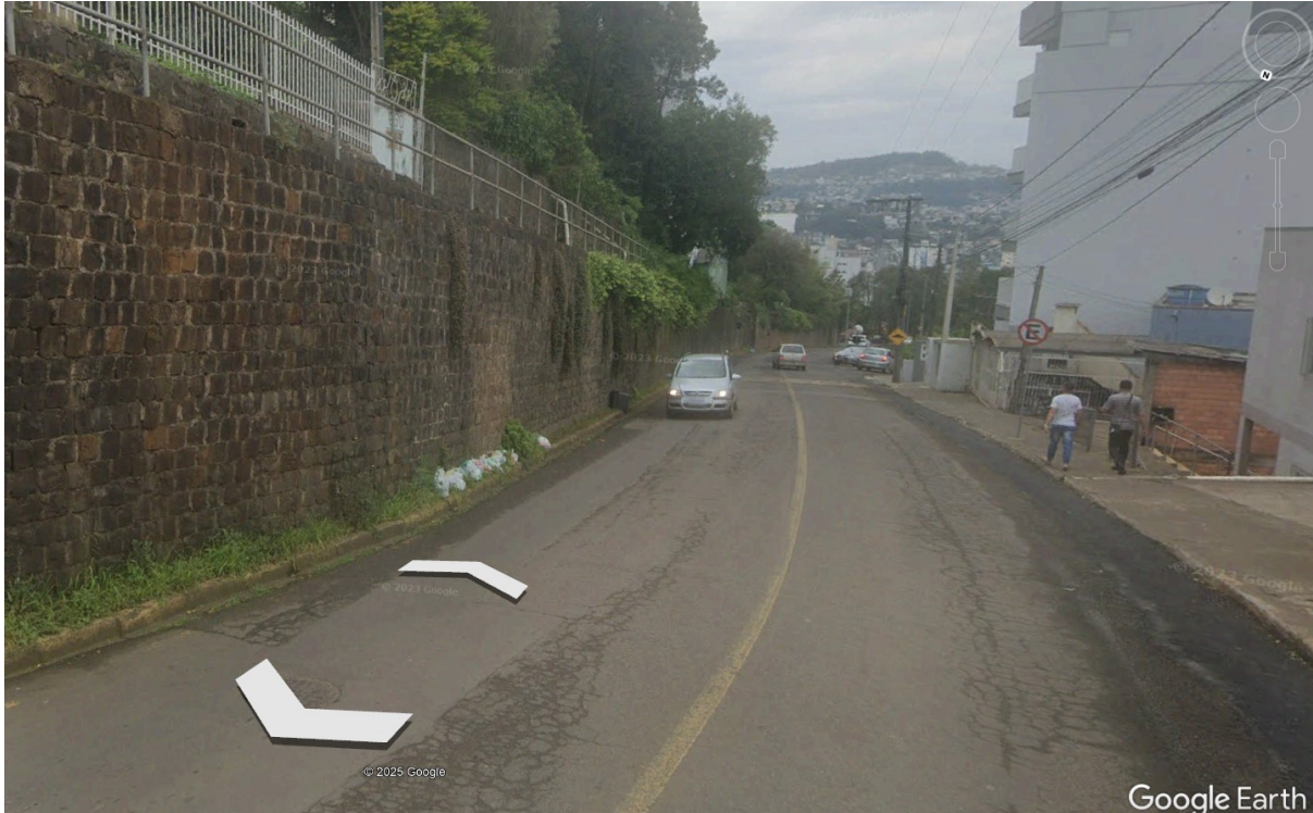
Foto 02 – Local antes do rompimento do muro – Fonte: Google 2025
