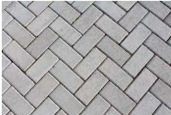
Figura 3: Assentamento tipo "espinha de peixe".
