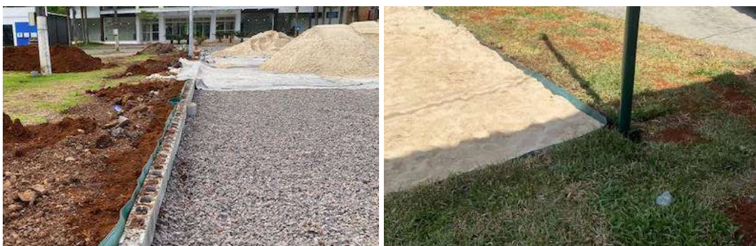
Figura 1: Fotos ilustrativas da execução de muretas e limitadores entre locais com piso em grama e areia.
