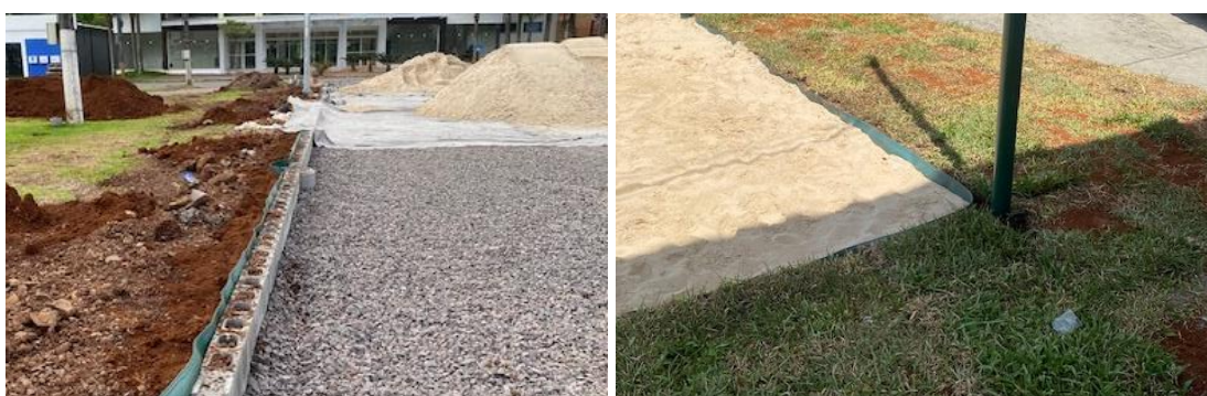
Figura 1: Fotos ilustrativas da execução de muretas e limitadores entre locais com piso em grama e areia.
