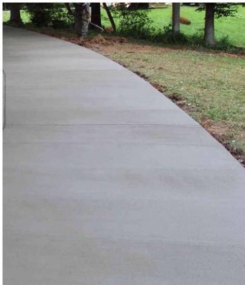
Figura 4: Referência para acabamento dos pisos cimentados.
