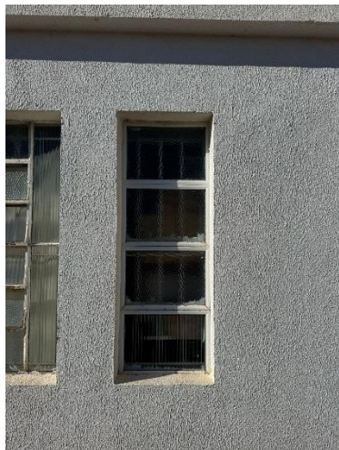
Fotografia 06 - Esquadria de ferro e vidro existente a ser removida.
