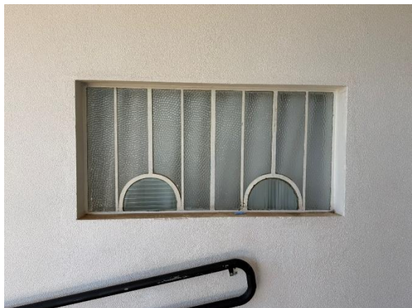
Fotografia 07 - Esquadria de ferro e vidro fixo existente a ser removida.
