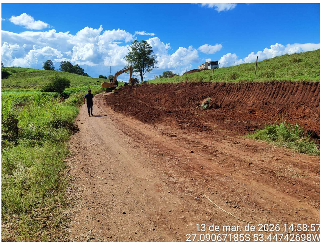
Imagem 20 – Alargamento da Via para posterior reforço do Sub-leito.
