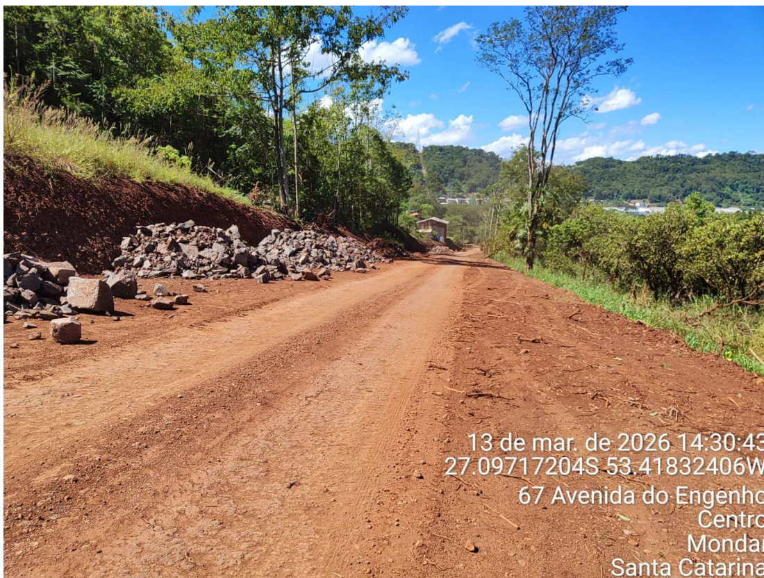
Imagem 19 – Material na lateral para reforço da sub-base da via.
