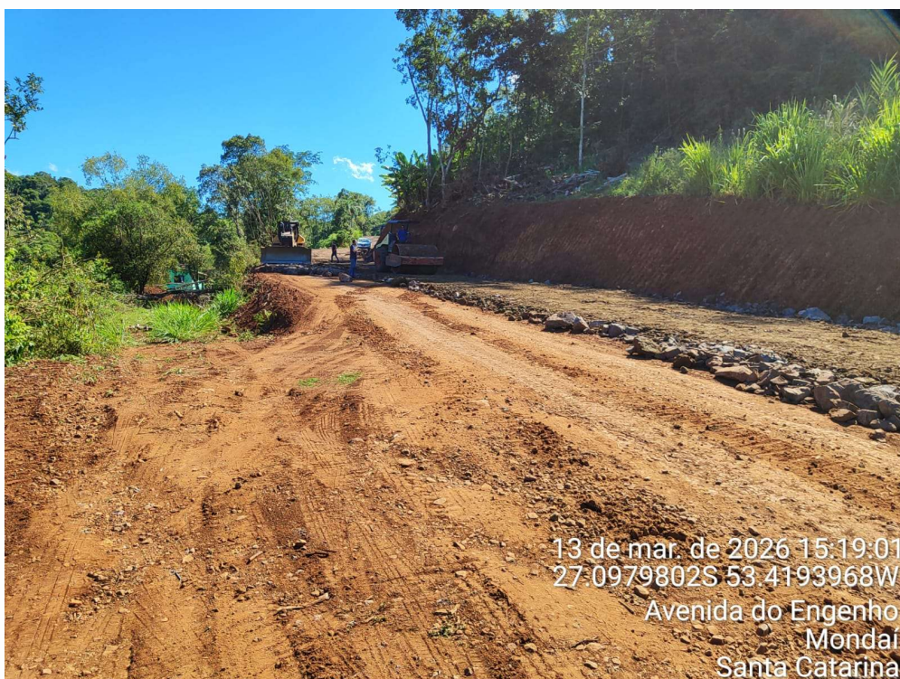
Imagem 18 – Pontos de reforço do subleito, executado pela municipalidade.
