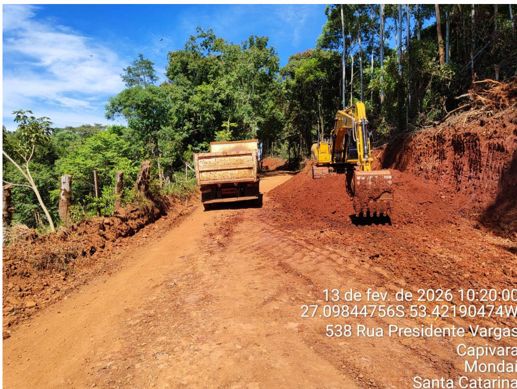
Imagem 15- Município realizando abertura e reforço do subleito.
