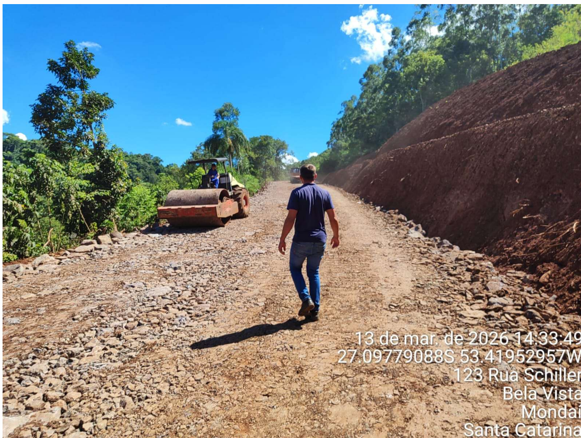
Imagem 21 – Trecho já com o reforço do Subleito e sendo compactado.
