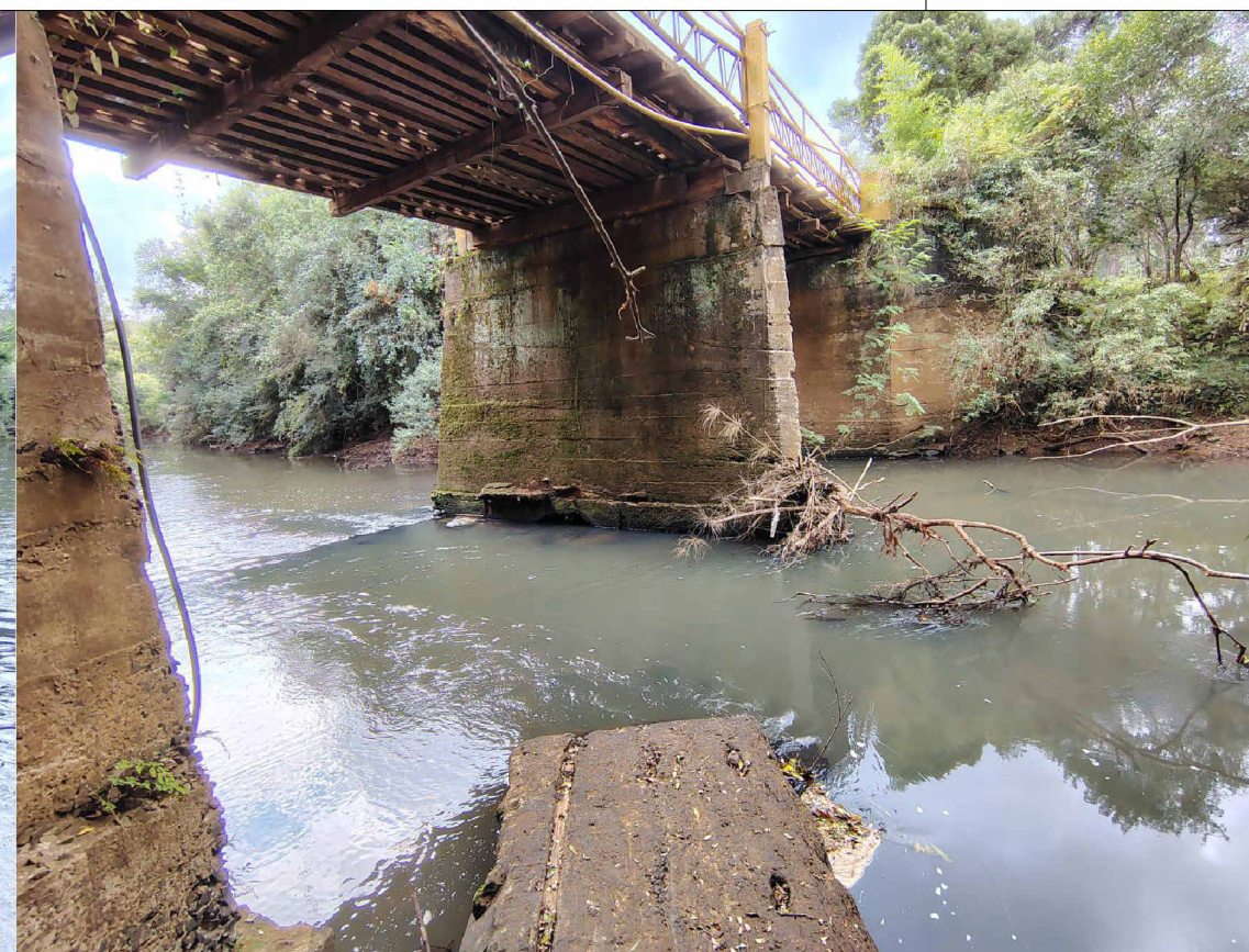
Imagem 3: Vista lateral da Ponte.
