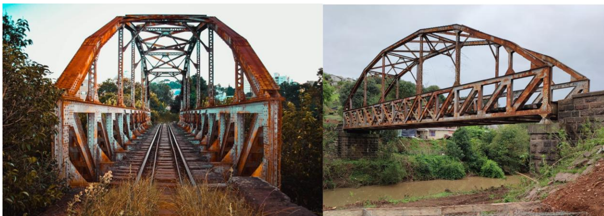
Fig. 3 – ponte pré restauração
