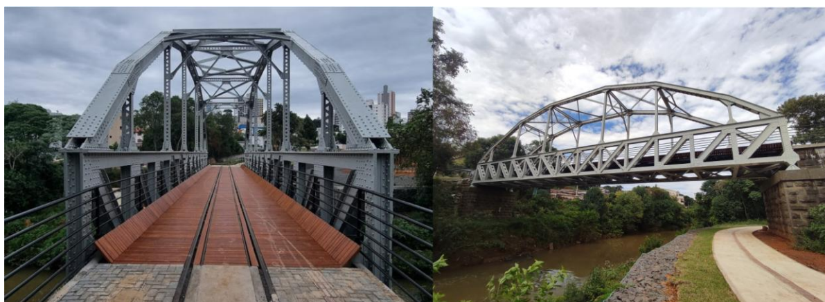
Fig. 4 – ponte pós restauração
