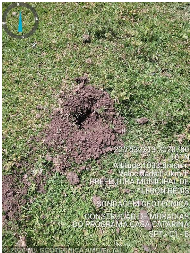
Foto 5 – SP-001 - Deslocamento B
