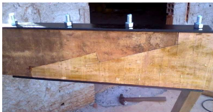
Imagem 01 – Exemplo de emenda a ser utilizada.
