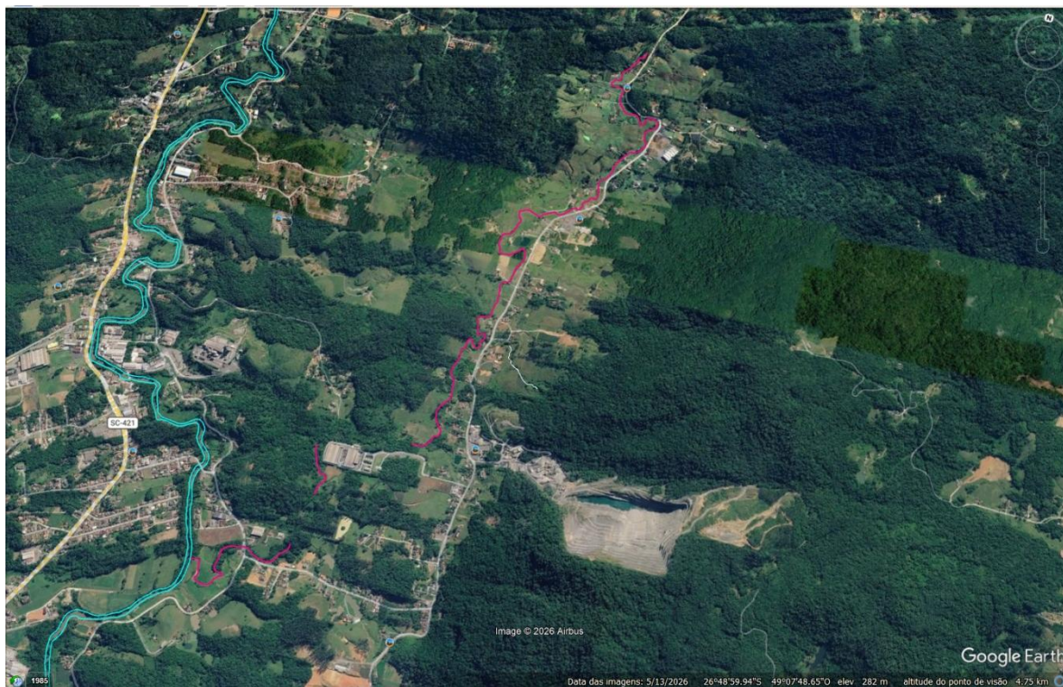
Figura 1. Imagem dos trechos a serem desassoreados do Ribeirão Vale do Selke, identificados pela linha de cor magenta.
