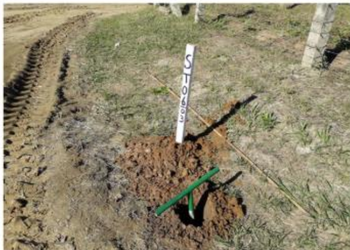
Execução da Sondagem
