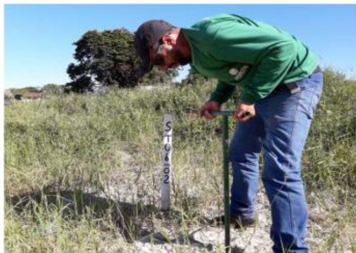
Execução da Sondagem
