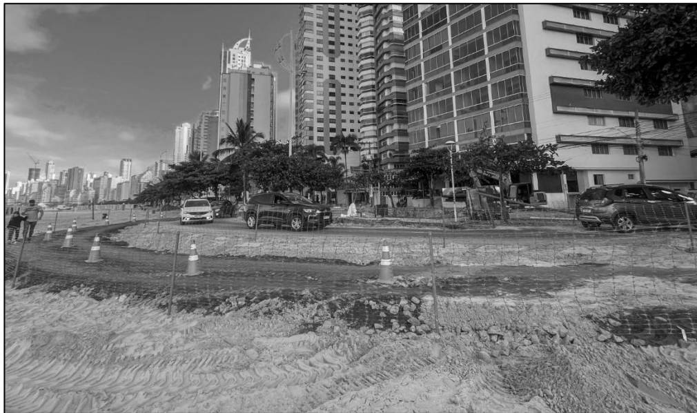
Figura 37 - Referência para desvio pela praia executado no trecho norte
