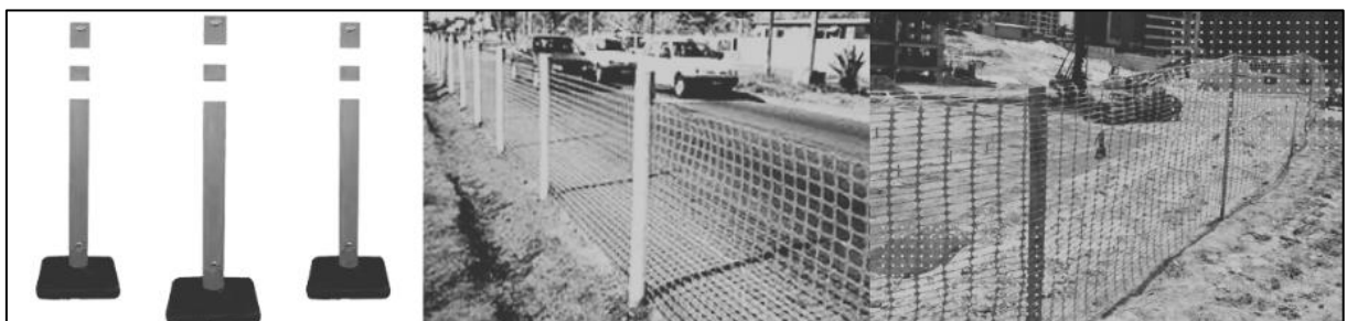
Figura 36 - exemplos de instalação de tapume de pvc
