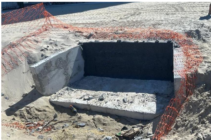
Figura 42 - Exemplo de instalação do sistema de fechamento do extravasor (execução do trecho norte)
