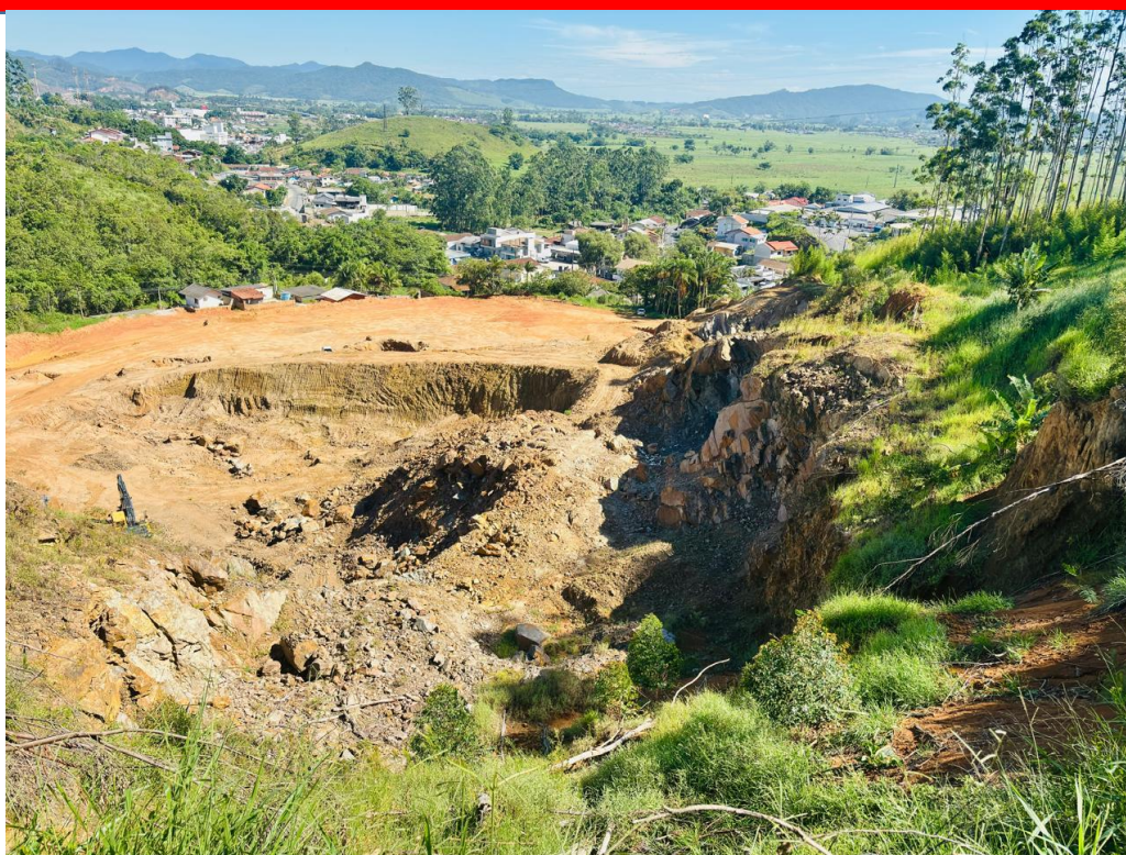
Anexo 5: Foto batida do terreno na parte mais alta, onde está sendo retirado o material, com vista para a frente do terreno.
