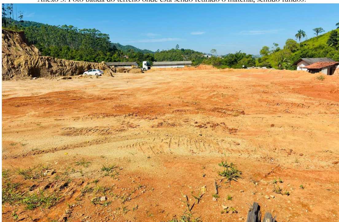
Anexo 4: Foto batida do terreno onde já foi retirado o material, fica próximo ao acesso ao terreno.
