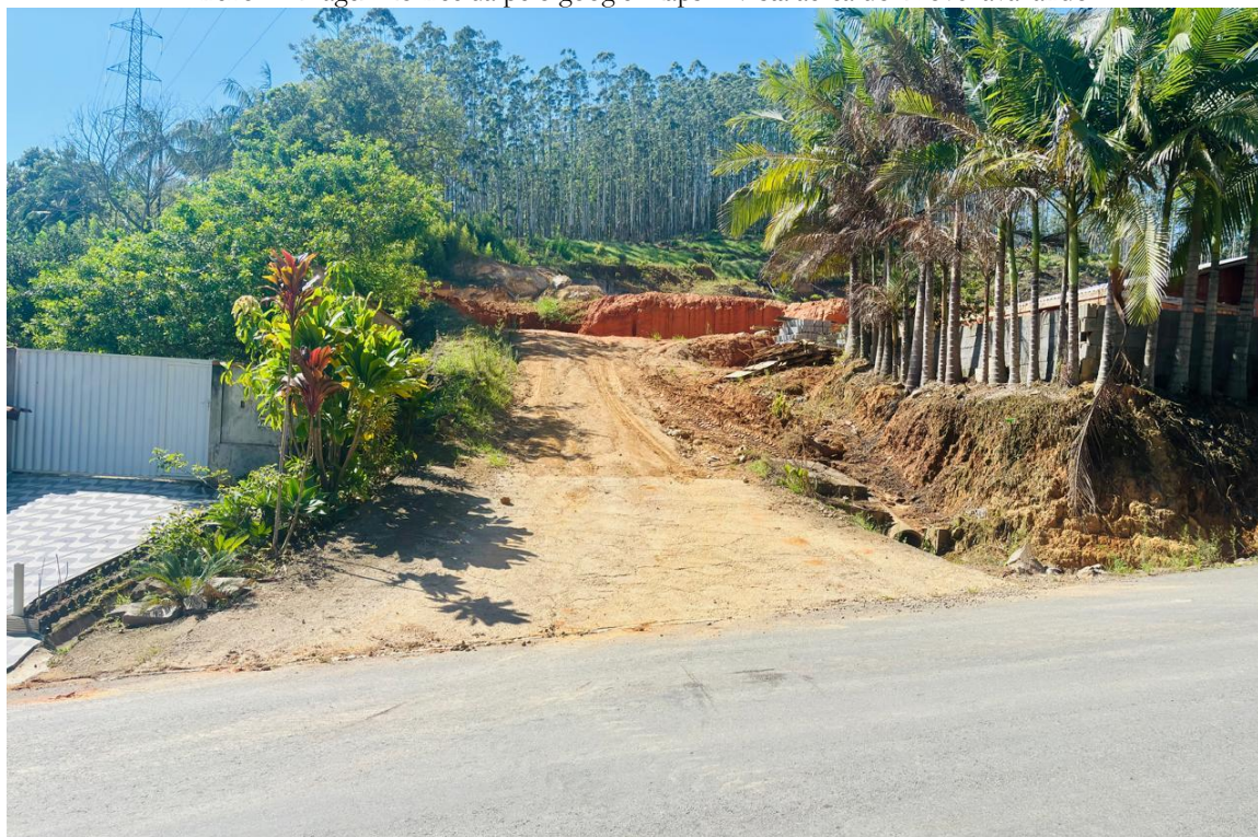
Anexo 2: Foto batida do acesso e a passagem dos caminhões e maquinário, frente para a rua João Domingos Pereira.
