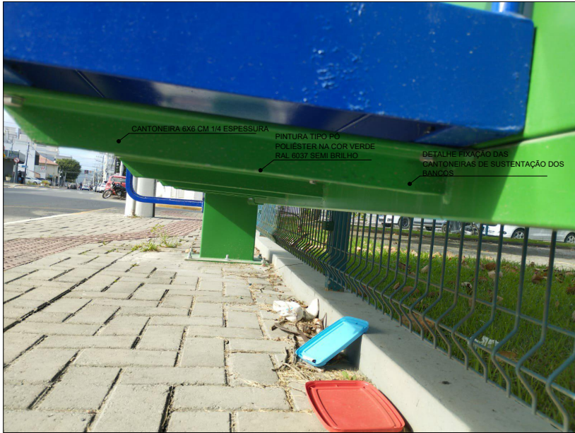
DETALHE FIXAÇÃO BANCO
