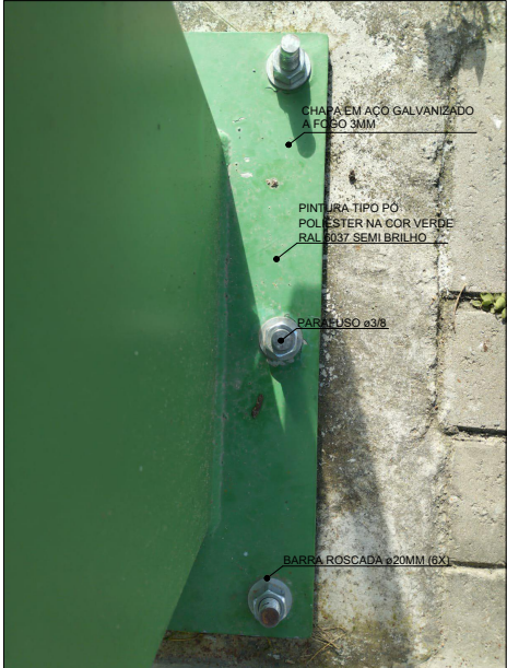
DETALHE FIXAÇÃO ESTRUTURA
