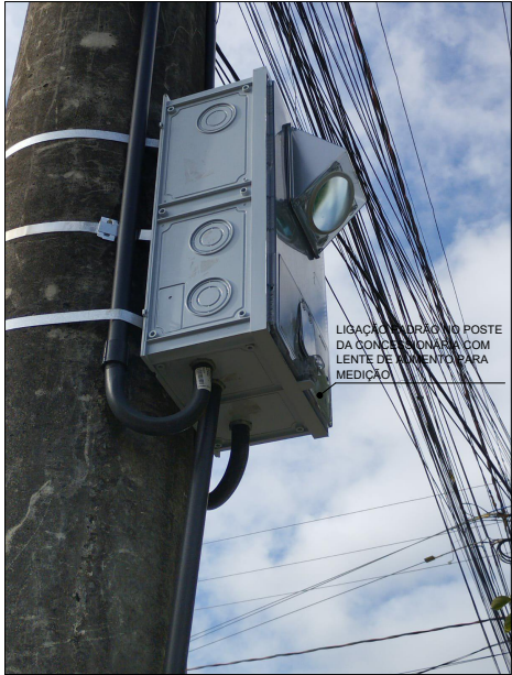
DETALHE LENTE DE AUMENTO PARA MEDIÇÃO
