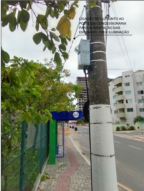
LIGAÇÃO DE LUZ JUNTO AO POSTE
