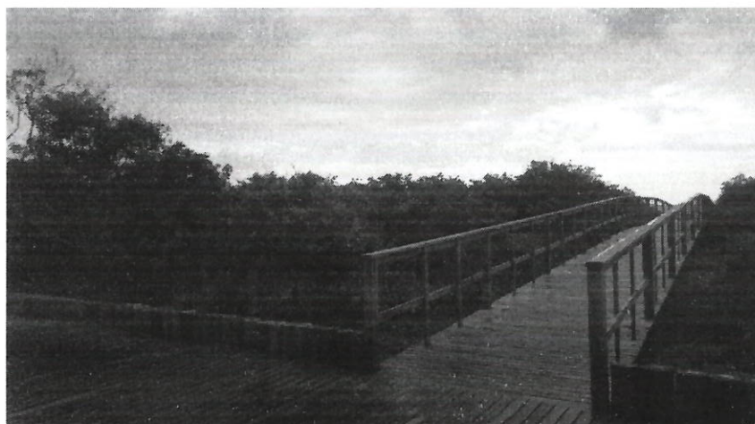
Figura 4: Vista parcial do PRAD com presença de vegetação característica do ecossistema de restinga bem desenvolvida.
