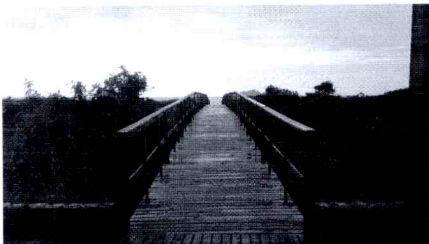
Figura 3: Passarela implantada de acordo com padrão estabelecido na Licença Ambiental.
