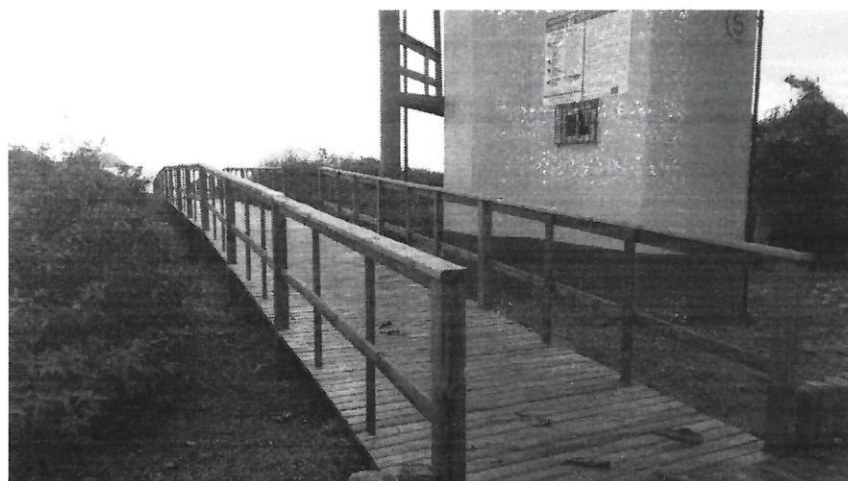
Figura 6: Passarela de acesso à praia implantada.
