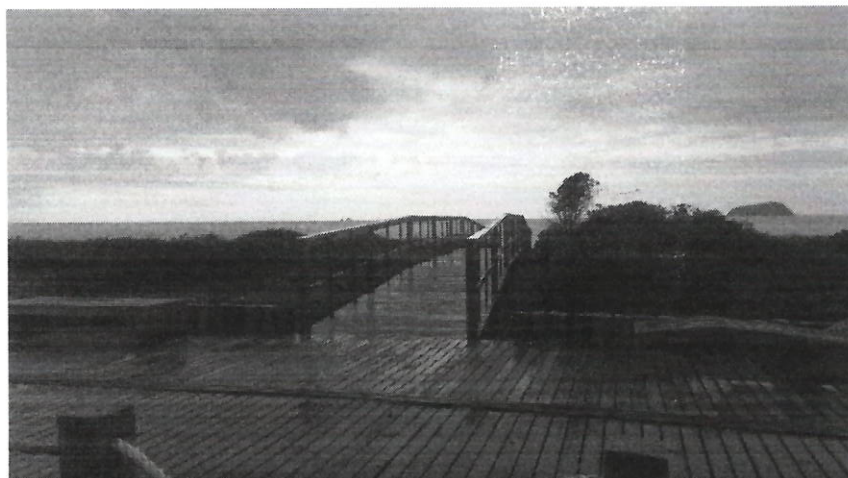
Figura 1: Passarela de acesso à praia implantada com presença de vegetação nativa em recuperação.
