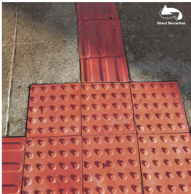
Figura 4: Placa de concreto tátil – ALERTA e DIRECIONAL. Cor: VERMELHA
