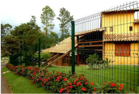
Figura 16: Execução do cercamento em níveis diferentes. Fonte: desconhecida
