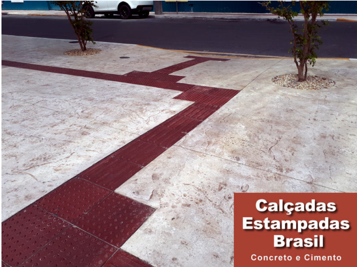
Figura 2: Modelo da estampa na parte lisa na cor cinza com piso de concreto tátil – alerta/direcional. Cor: vermelha
