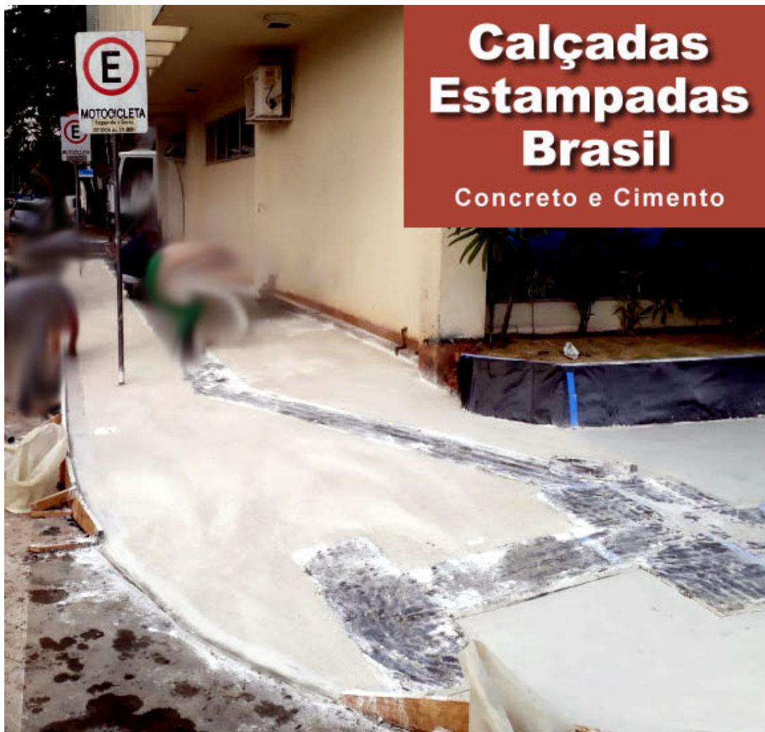
Figura 3: Proteger com lona as placas táteis para concretagem e acabamentos do piso de concreto estampado.
