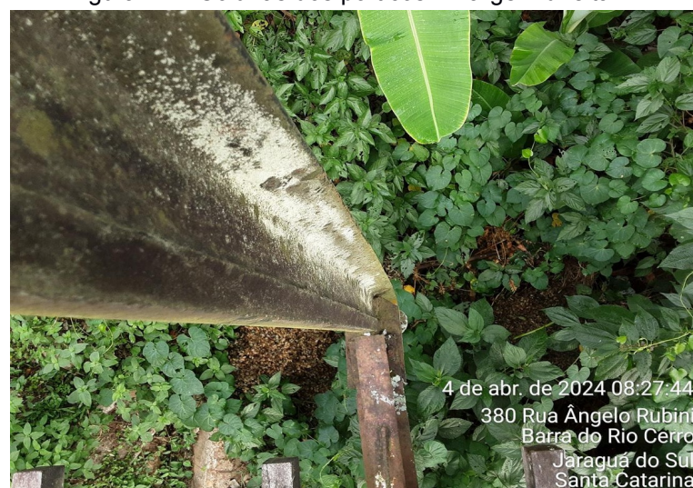
Figura 11 – Colunas dos pórticos - margem direita
