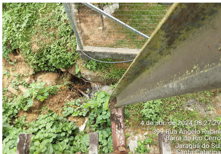
Figura 10 – Colunas dos pórticos - margem direita
