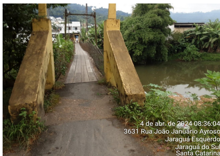
Figura 3 - Ponte Pênsil Sobre o Rio Jaraguá – Bairro São Luis
