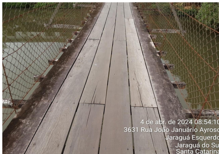
Figura 8 – Tabuleiro de madeira
