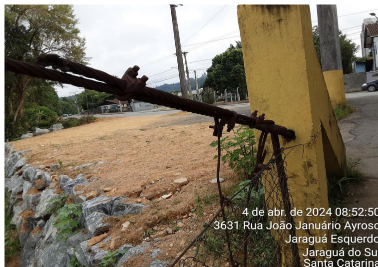
Figura 14 – Ancoragem pórtico – margem esquerda
