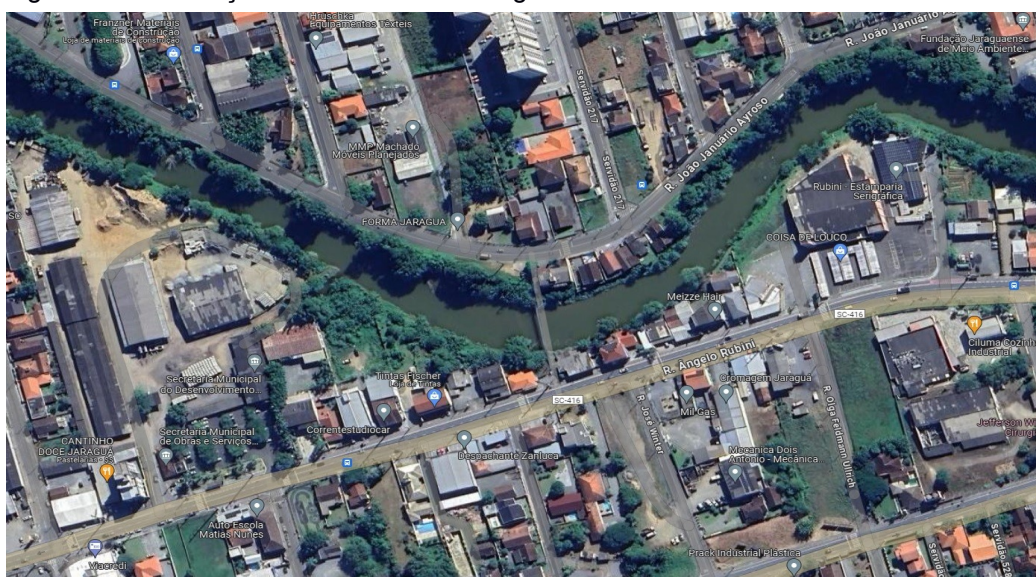
Figura 1 - Localização da Ponte Pênsil – Ligando Bairros Barra do Rio Cerro / São Luis
