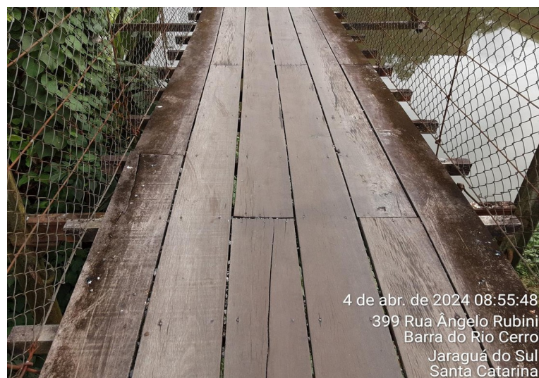
Figura 7 – Tabuleiro de madeira
