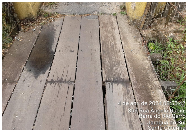
Figura 6 – Tabuleiro de madeira
