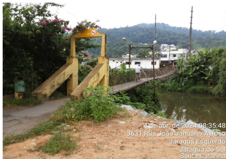
Figura 5 – Ancoragem – Bairro São Luis
