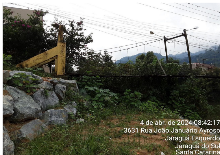
Figura 13 – Detalhe estrutura - margem esquerda
