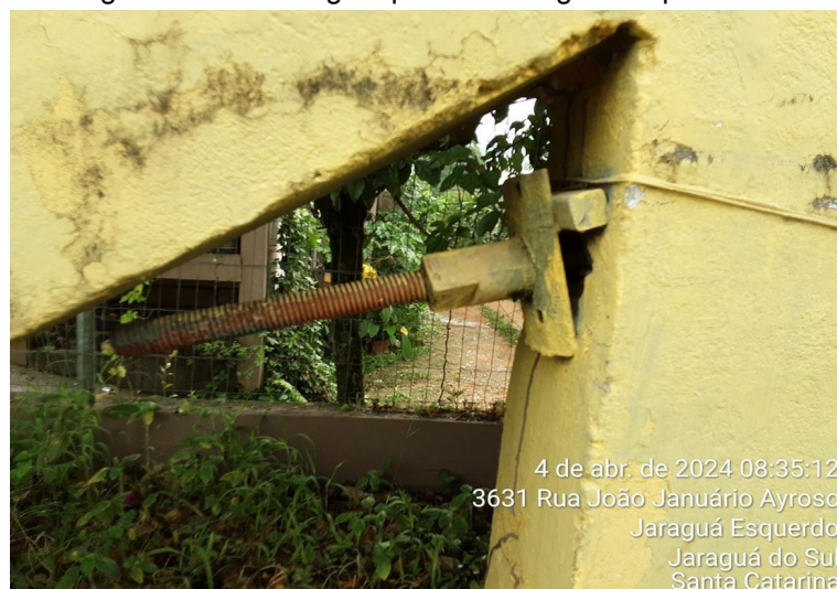
Figura 15 – Ancoragem pórtico - margem esquerda
