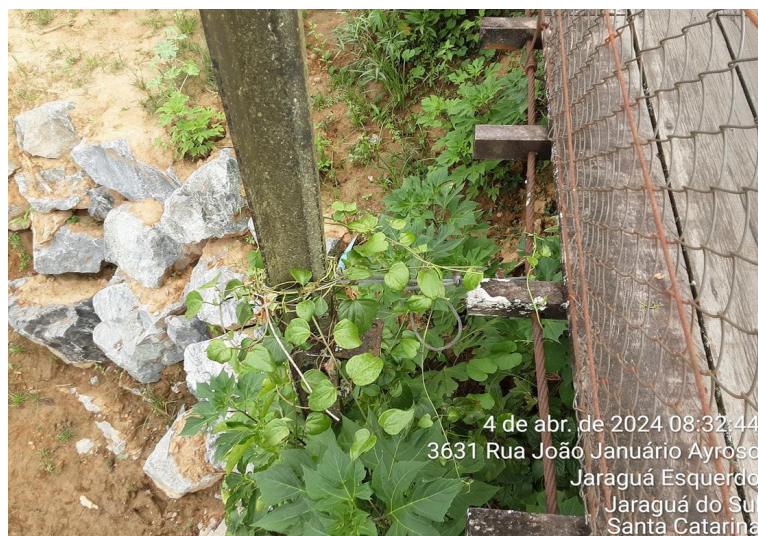
Figura 12 – Colunas dos pórticos - margem esquerda
