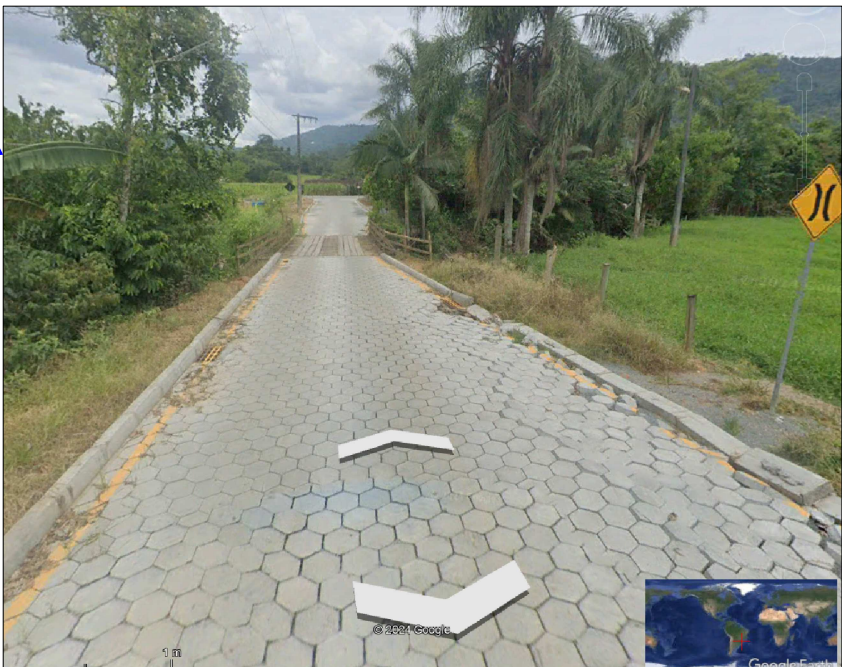
FOTO DA PONTE - CABECEIRA 02
