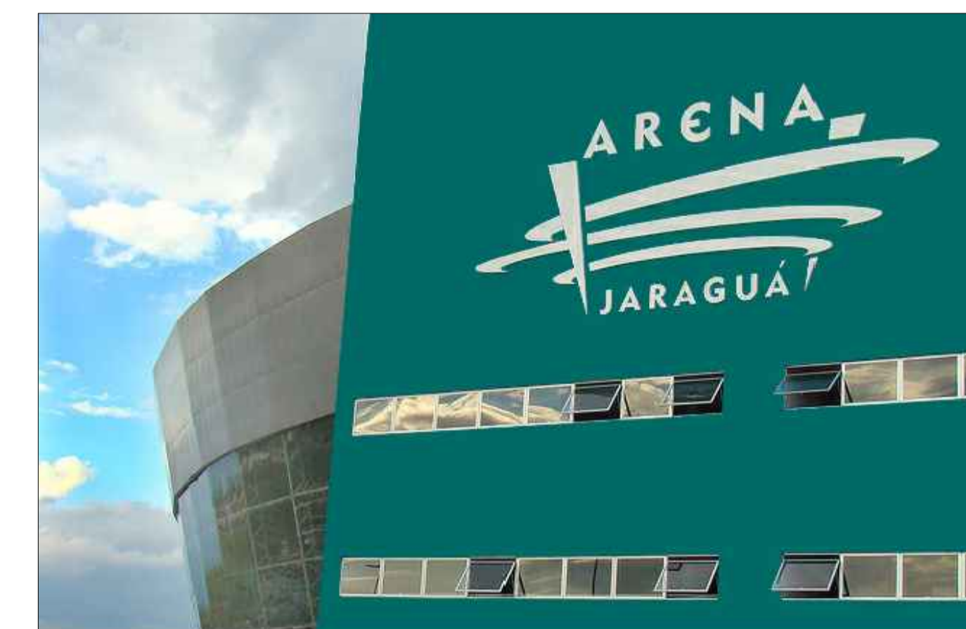
FOTO 03 - VISTA DA TORRE E LOGOMARCA ARENA JARAGUÁ COR DE REFERÊNCIA SHERWIN WILLIAMS SW 6769 TEMPO CERTO
