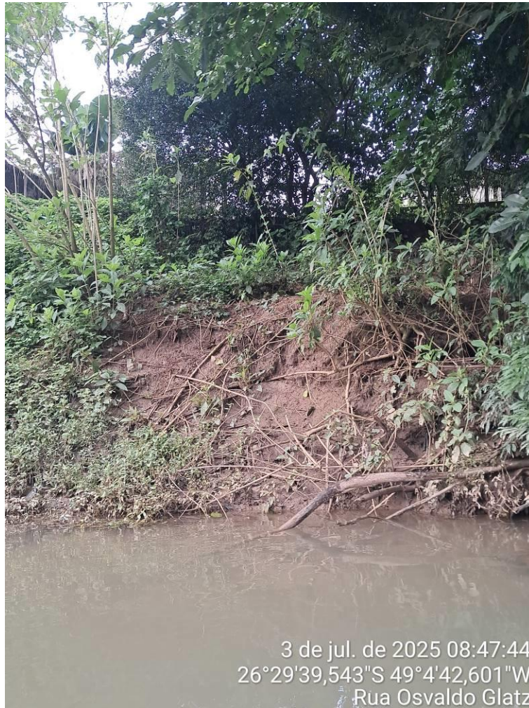
Foto 07 – Processo erosivo margem do rio (proximidade área lazer prédios – bairro Vila Nova)
