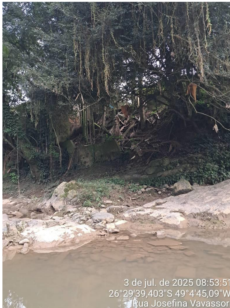
Foto 01 – Local que será construído o muro de concreto sobre rochas (muros residenciais colapsados – bairro Centro)
