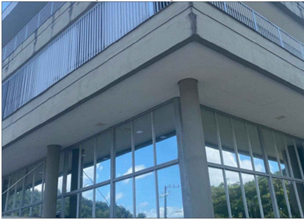
Imagem 03 - Forro de gesso externo
