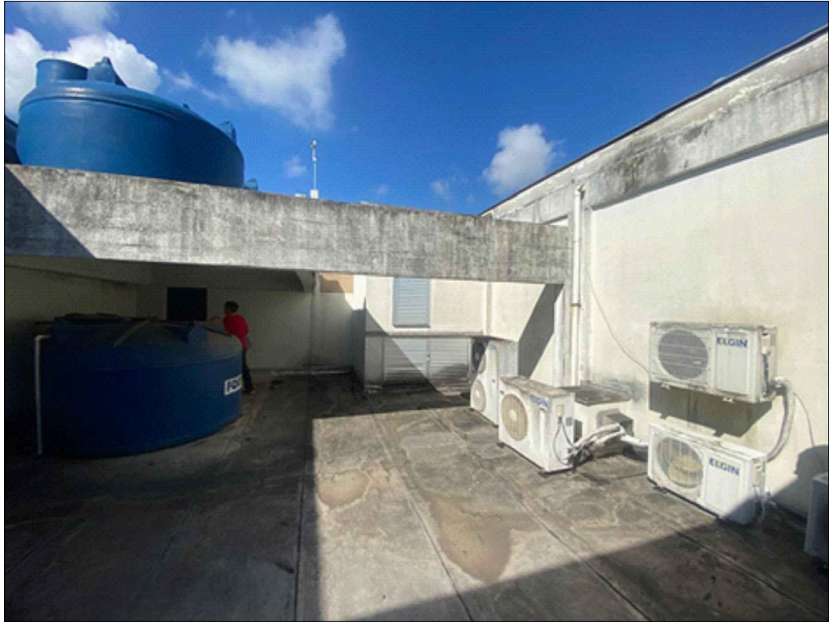
Imagem 01 - Paredes internas reservatório
