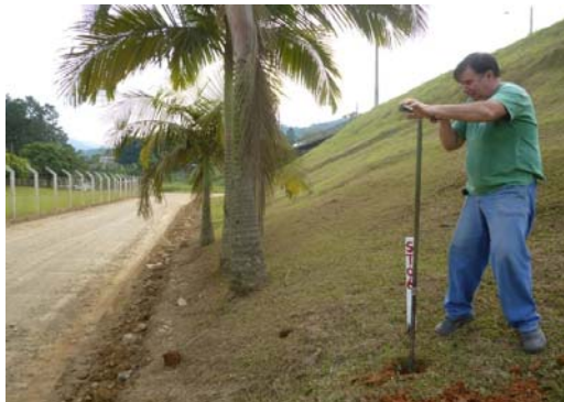
Execução da Sondagem
