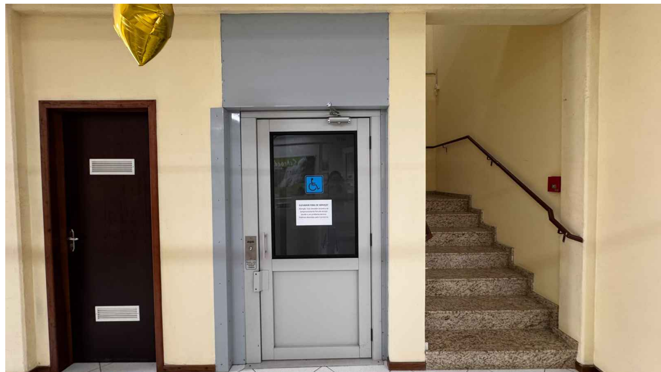
FOTO EM PERSPECTIVA ELEVADOR EXISTENTE A SER REMOVIDO
