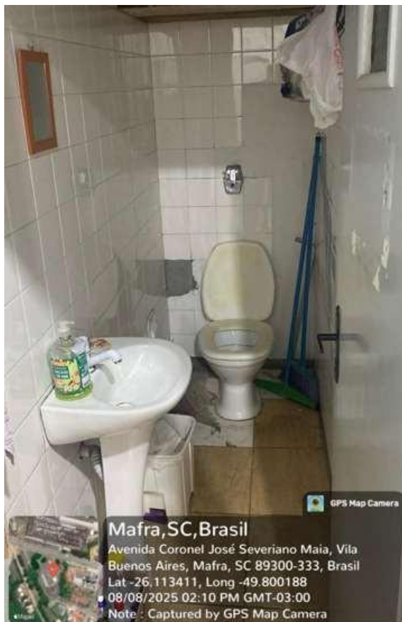
Foto 3 – Vista Interna do Banheiro da Sala Comercial
