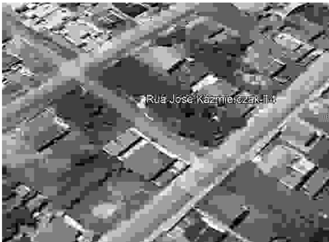
Figura 2.1 – Imagem Aérea do Empreendimento
