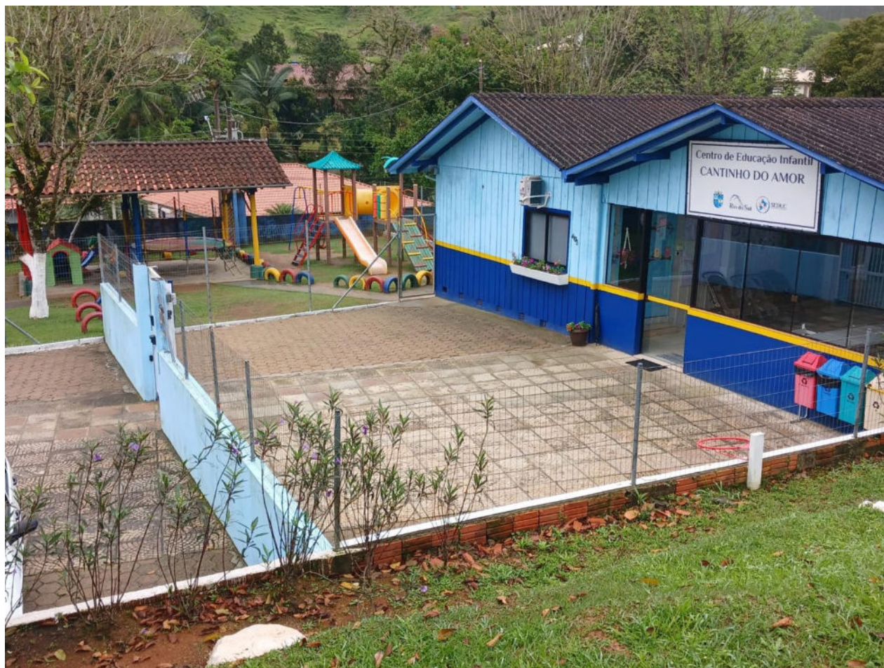
LOCAL DA INSTALAÇÃO DO ACESSO COBERTO.
