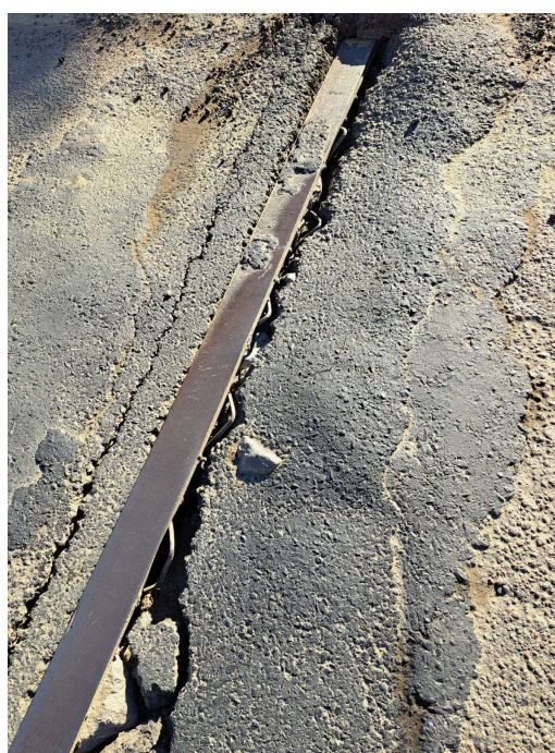
Figura 02 – Exposição armadura de chumbamento das cantoneiras metálicas
