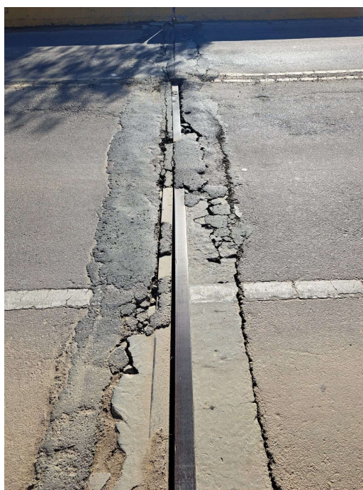
Figura 04 – Deslocamento total entre berços de concreto e pista de rolamento
