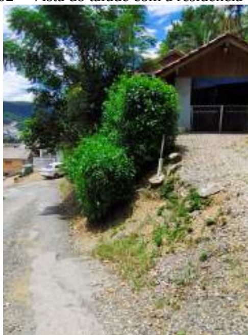
Figura 02 – Vista do talude com a residência existente
