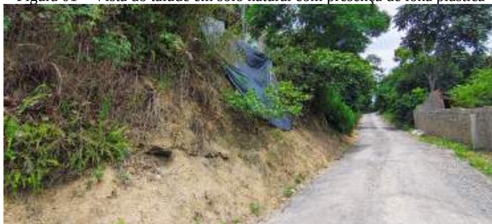
Figura 01 – Vista do talude em solo natural com presença de lona plástica
