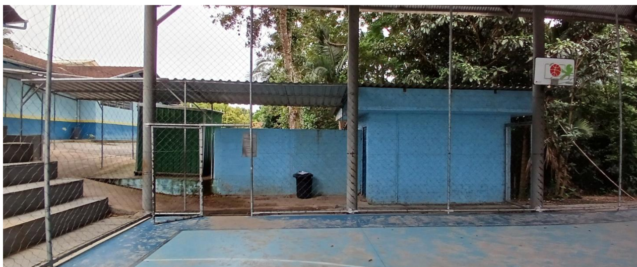
Local da construção dos sanitários
