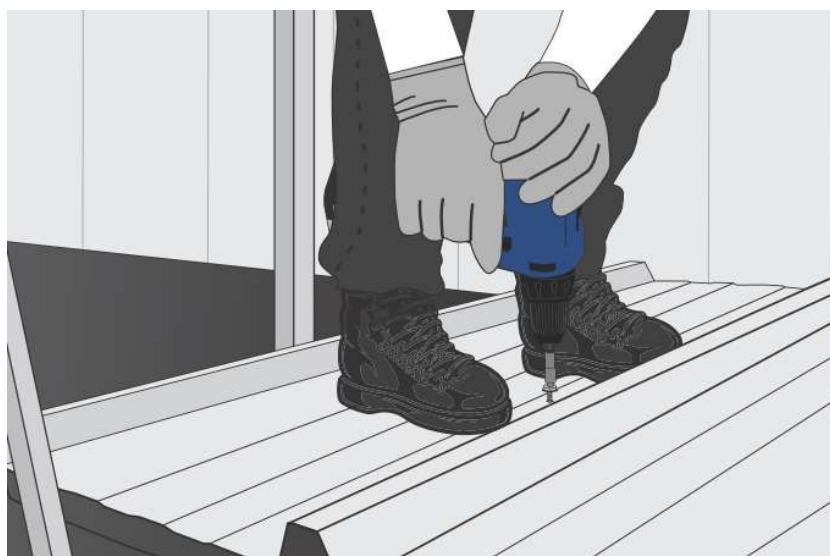
Figura 6: Início execução telha termoacústica.
