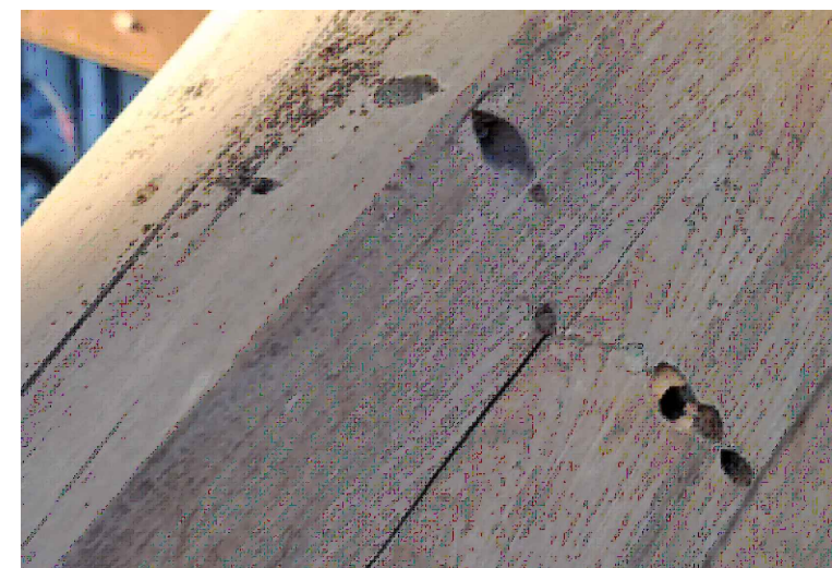
V9 TESOURA EXISTENTE - LEVANTAMENTO DE REGIÕES DANIFICADAS ESC: 1/50
