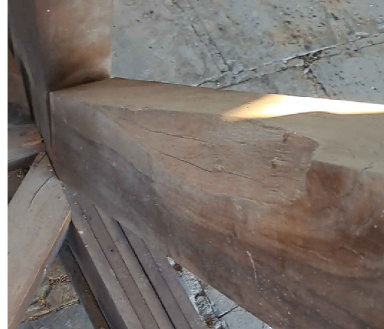
V9 TESOURA EXISTENTE - LEVANTAMENTO DE REGIÕES DANIFICADAS ESC: 1/50
