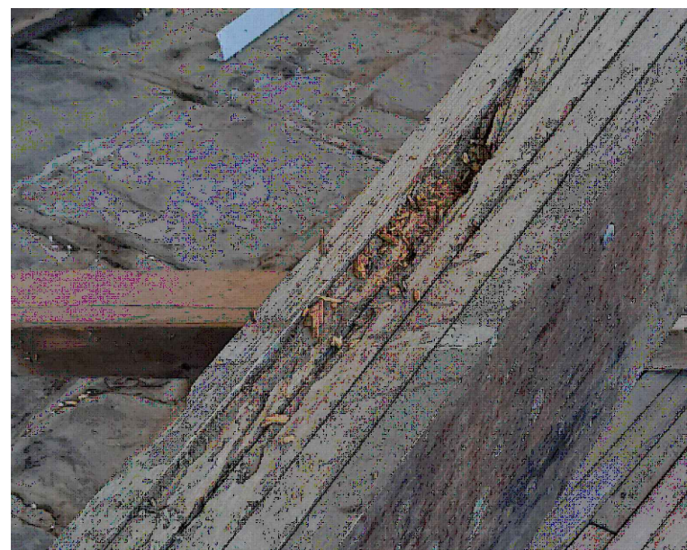
V9 TESOURA EXISTENTE - LEVANTAMENTO DE REGIÕES DANIFICADAS ESC: 1/50
