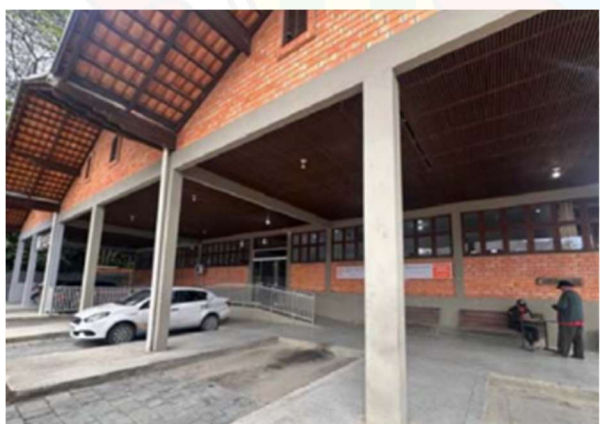
área externa coberta
