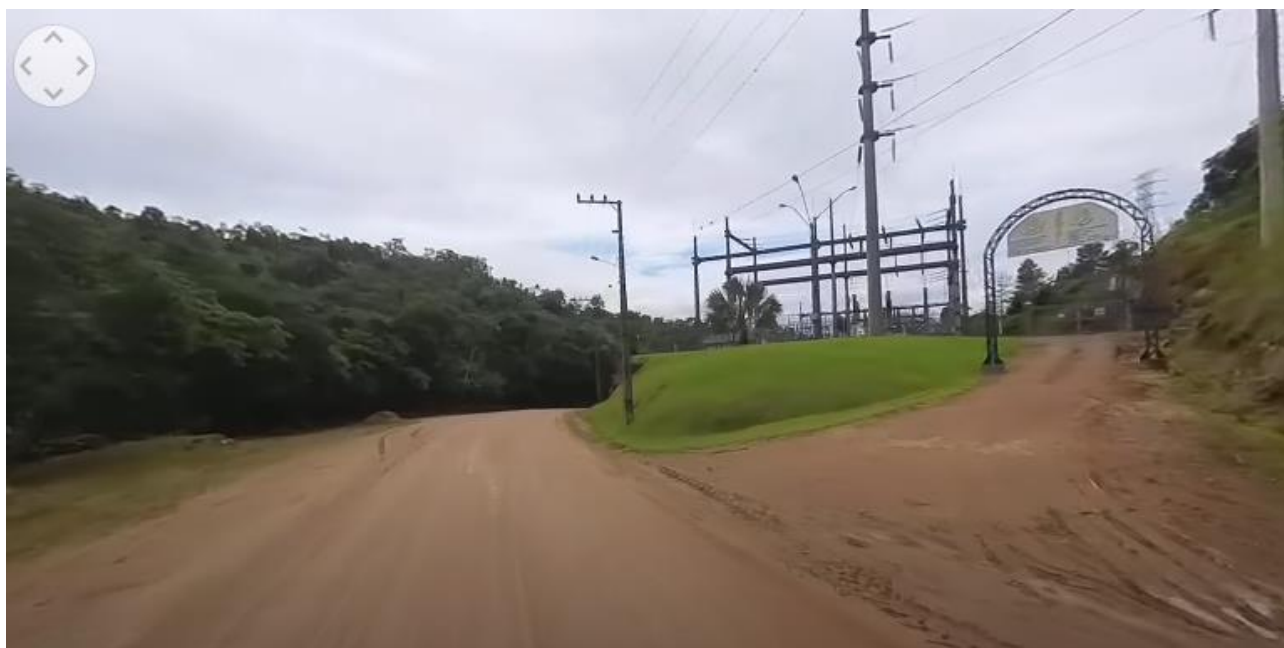
Figura 5 - Trecho próximo a subestação de energia
