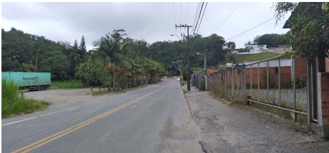
Foto 03 – início da obra na estaca 02
