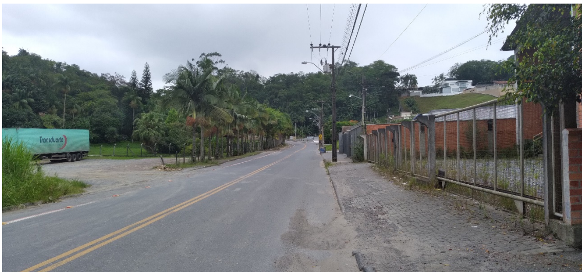
Foto 03 – início da obra na estaca 02
