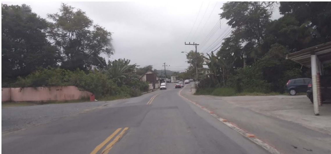
Foto 01 – Início da obra – entroncamento Rua Dr. Pedro Zimmermann
