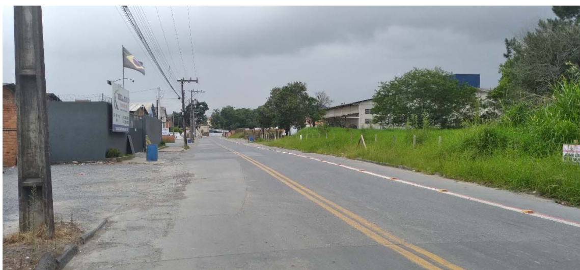
Foto 02 – meio da obra – estaca 11
