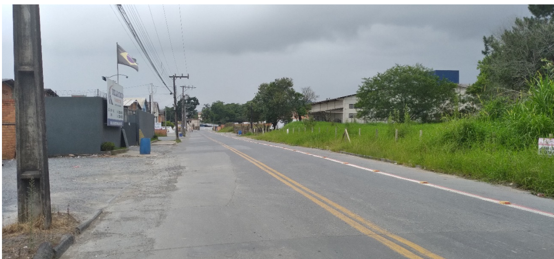
Foto 02 – meio da obra – estaca 11
