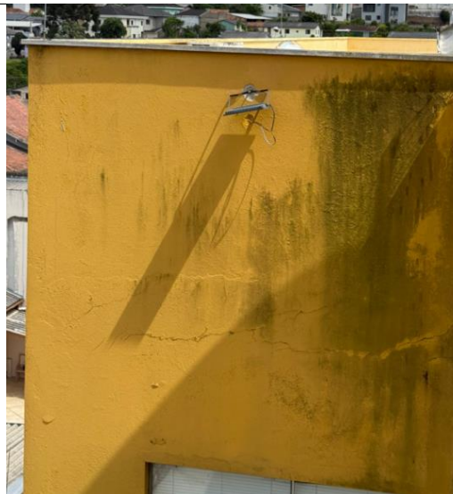
Remoção de argamassa e tratamento com tela poliéster
