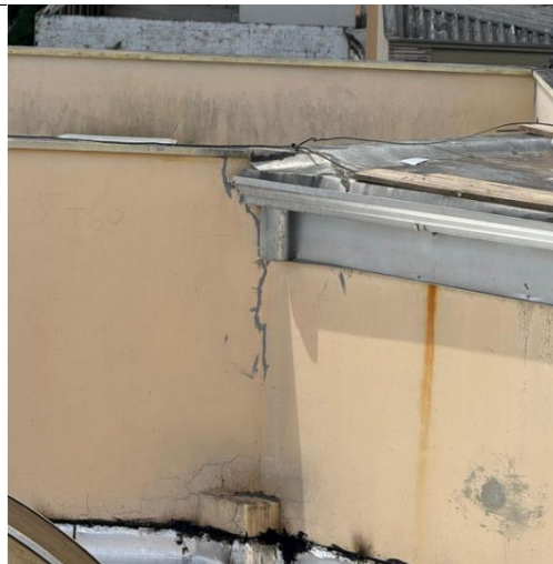
Reparo de fissuras e trincas
