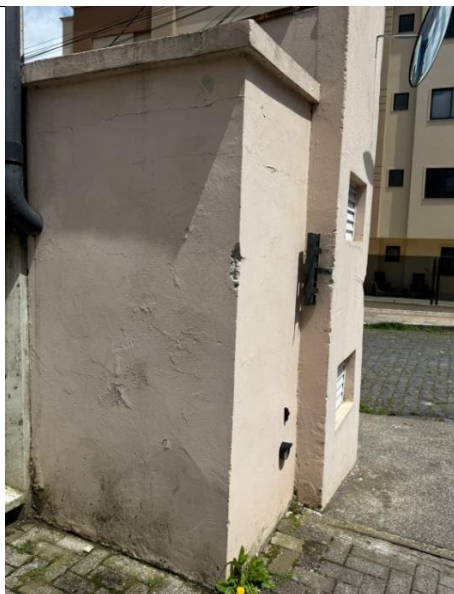
Demolição de argamassa, aplicação manual de massa acrílica
