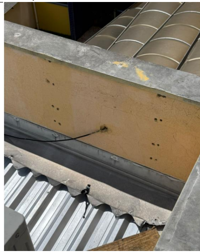
Reparo de fissuras e trincas e Aplicação de massa acrílica
