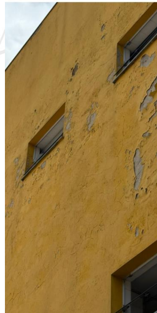
Remoção de argamassa, aplicação de massa acrílica e tratamento para fissuras e trincas
