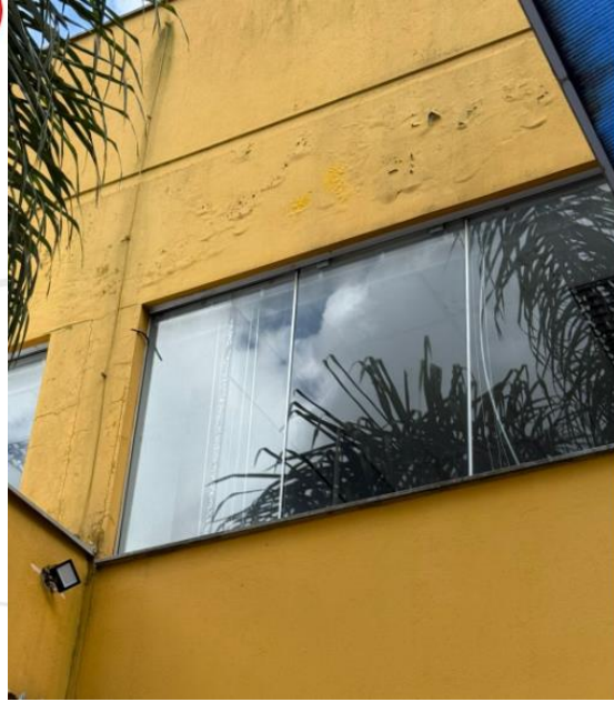
Remoção de argamassa e aplicação de massa acrílica
