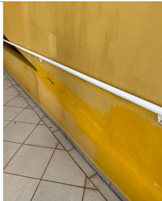
Demolição de argamassa e tratamento de junta de dilatação
