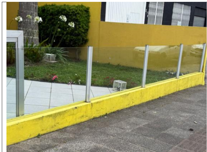
Demolição de argamassa e aplicação de massa acrílica
