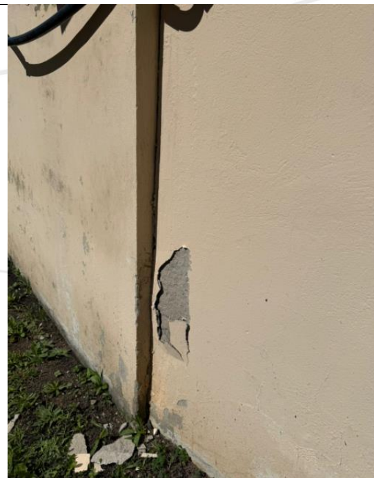
Demolição de argamassa e tratamento de junta de dilatação
