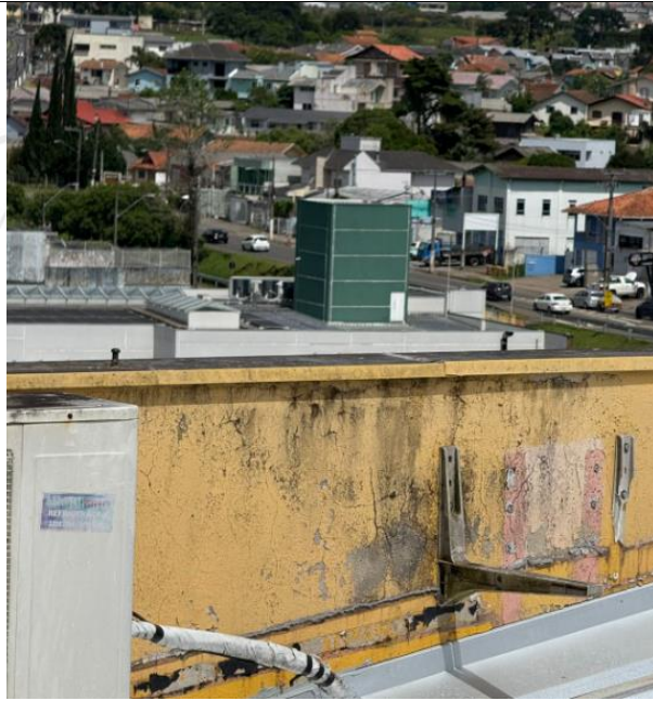
Remoção de argamassa e tratamento com tela poliéster
