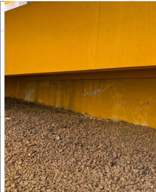
Demolição de argamassa, aplicação manual de massa acrílica
