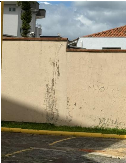
Reparo de fissuras e trincas
