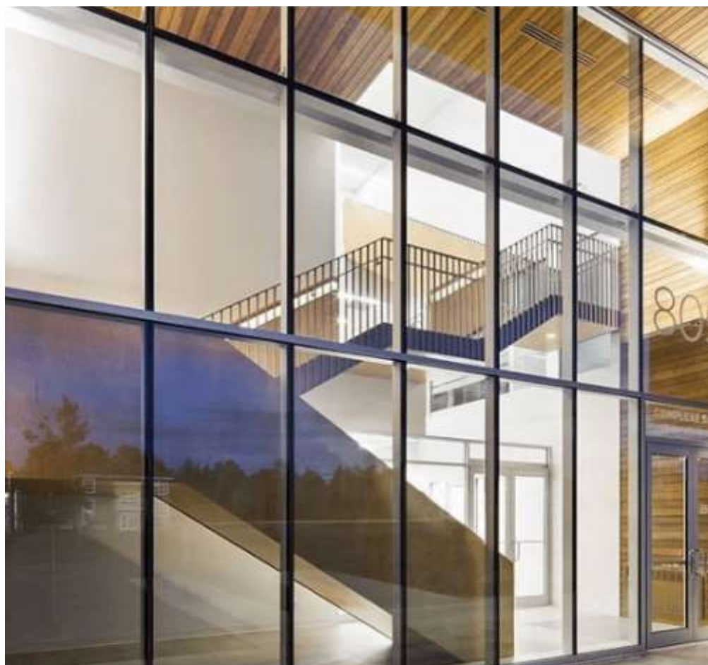
Sistema unitizado com esquadrias aparentes (vidro recuado no projeto).
