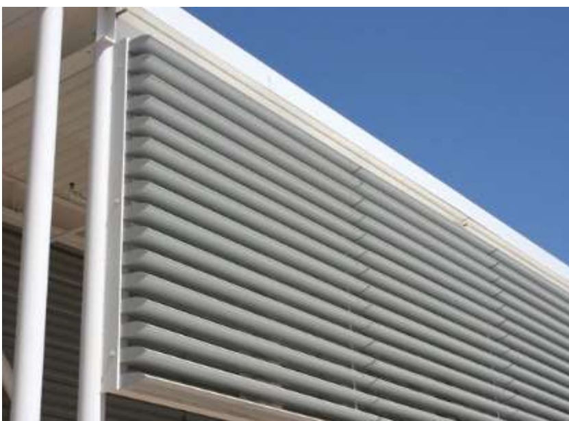
Brises metálicos, com estrutura posterior. Seção oval ou retangular.
