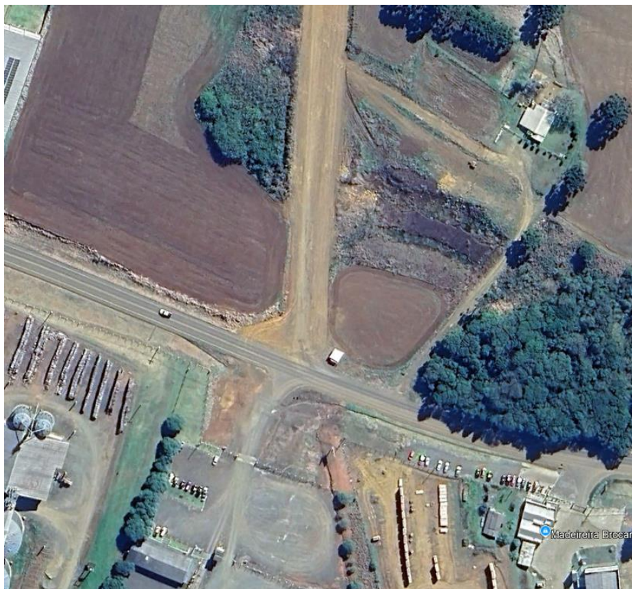
Figura 1 – Interseção entre SC-451 e rua Alfredo Granemann Drissen (não pavimentada), no centro da imagem: local onde será executado o trevo.
