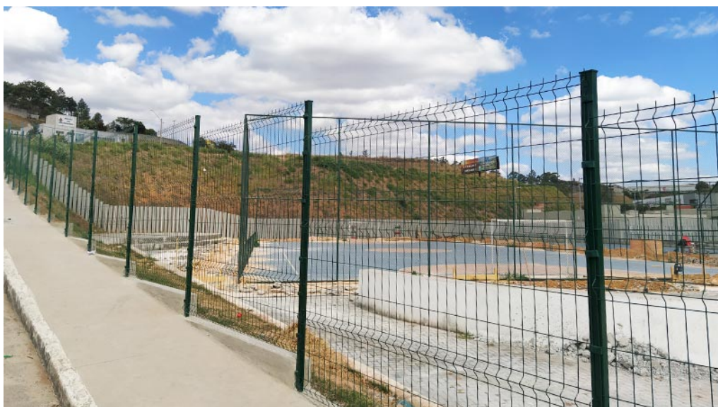
Figura 3 – Gradil em degrau com poste de altura maior para compensar a diferença. Fonte: https://www.gradilmorlan.com.br/
