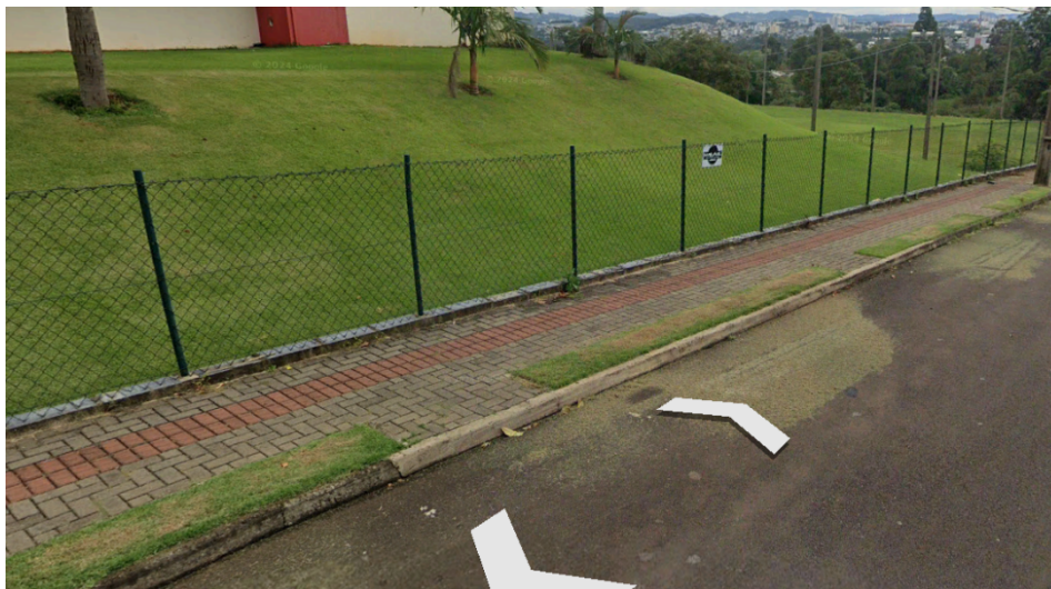
Figura 1 – Mureta de pedra existente, acompanhando a declividade do terreno.
