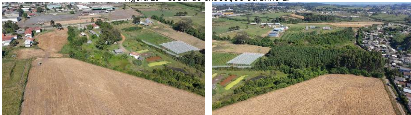
Figura 25 – Local de execução da Linha 2.
