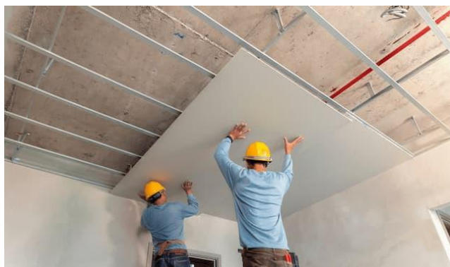
Figura 8 - Forro em gesso acartonado
