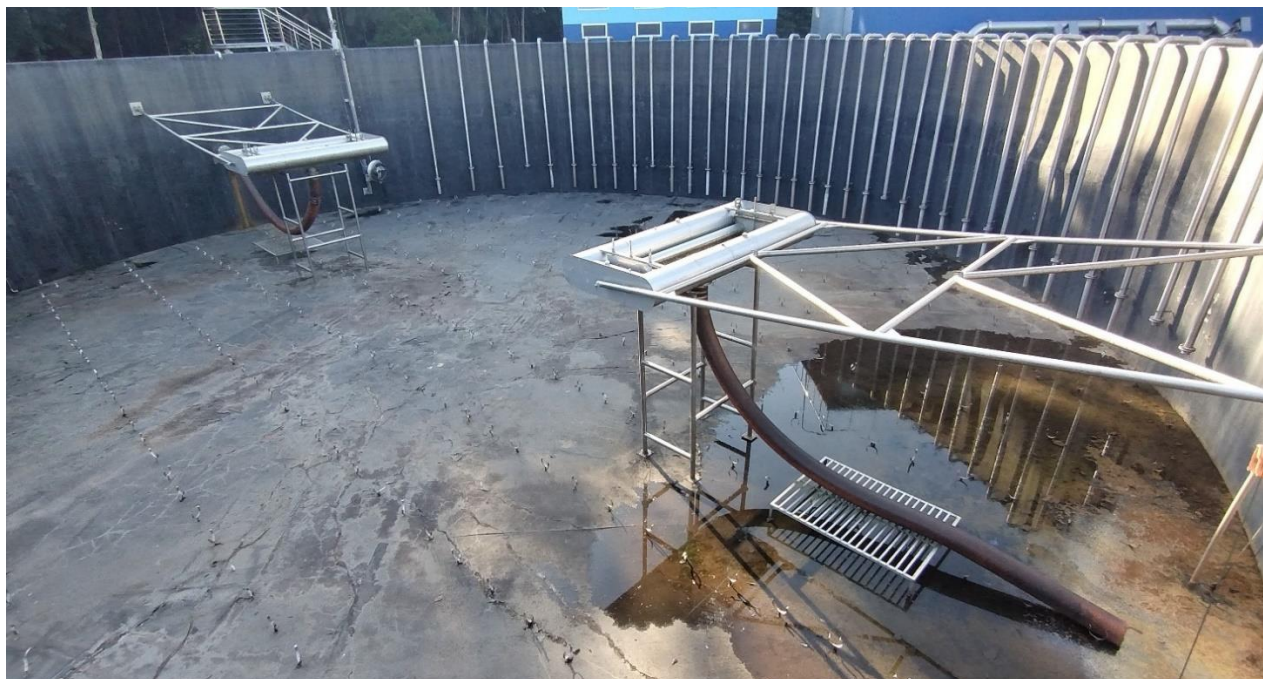
Imagem 07 – Reator aeróbio que será objetivo da instalação do sistema de aeração.
